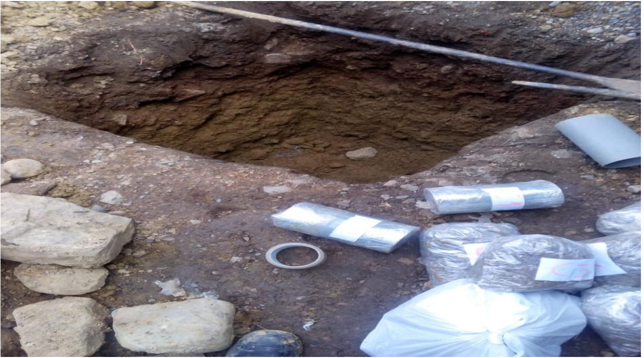
Figura 5: realización de calicatas y toma de muestras
