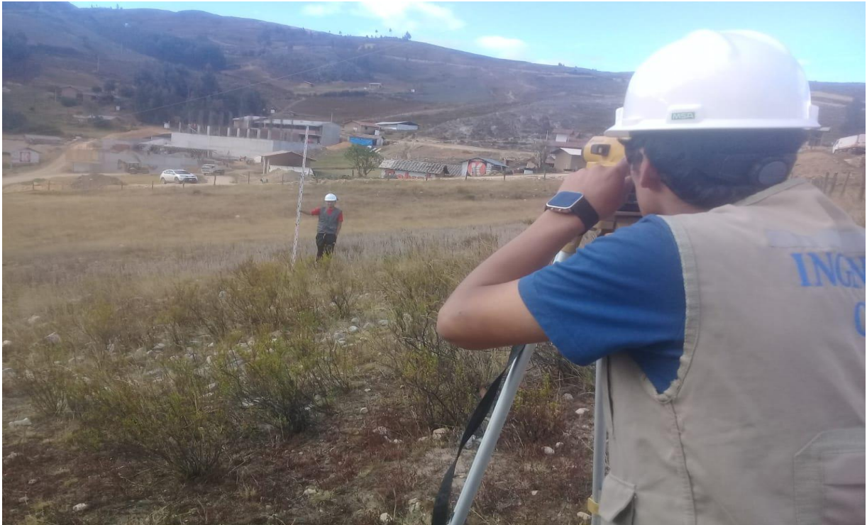
Figura 3: nivelación de terreno.
