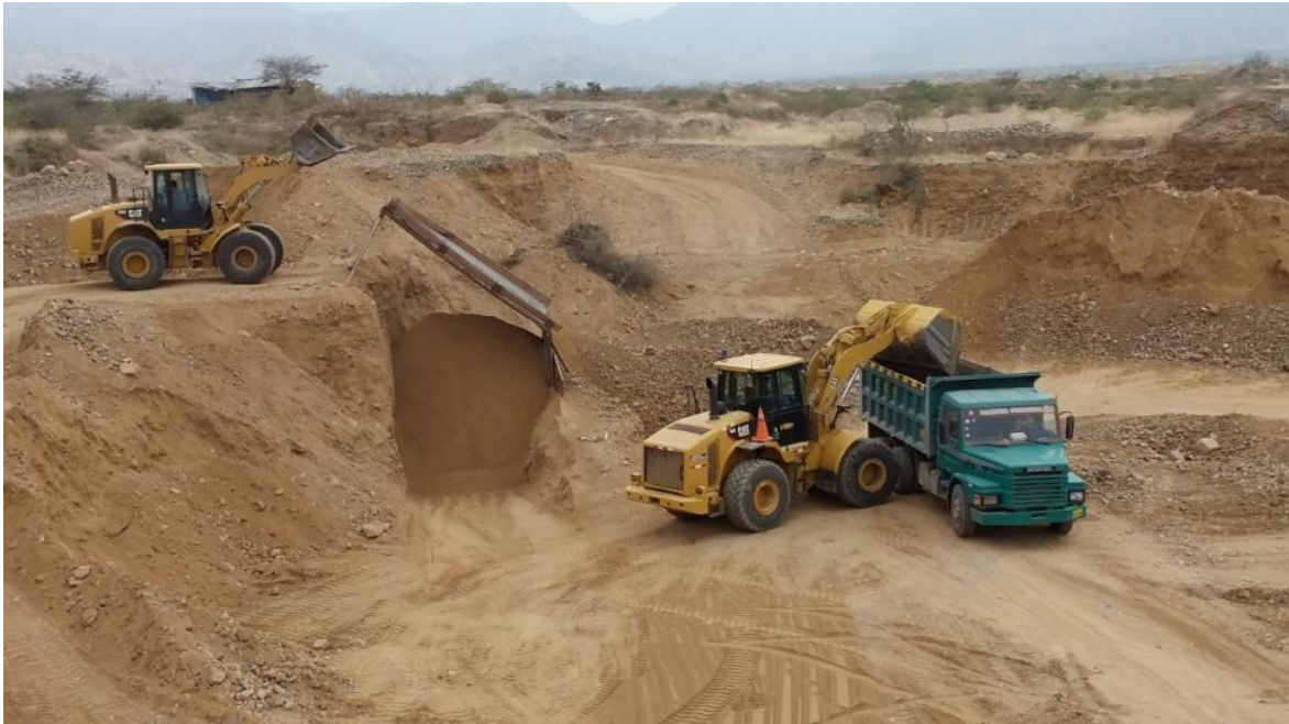
Labores de despacho en el sector El Huevo en la cantera Pátapo La Victoria S.A.
