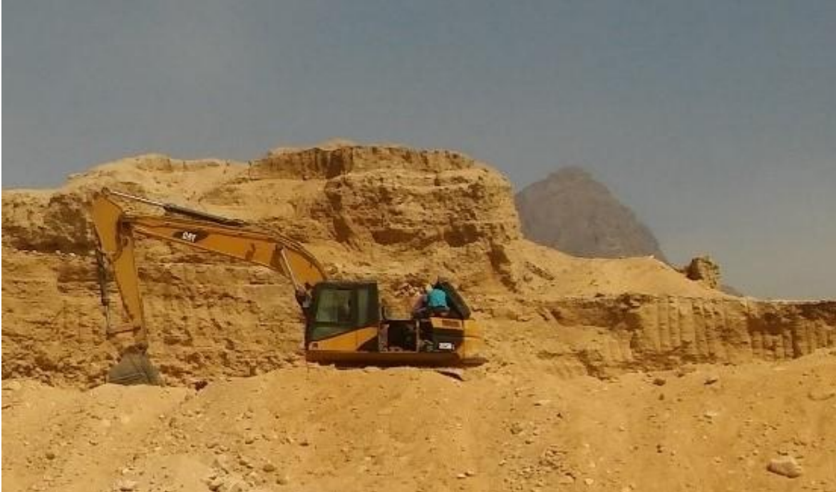
Labores de arranque de áridos en frente de explotación en el sector El Hueco en la cantera Pátapo La Victoria S.A.
