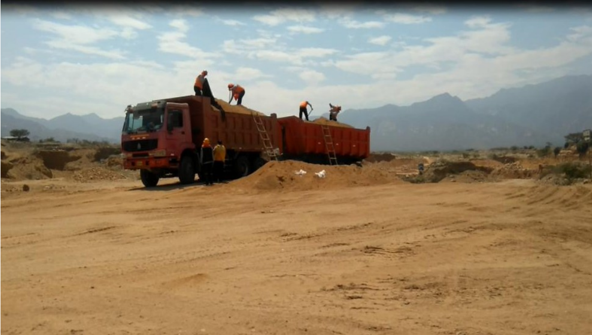
Labores de emparejado en el sector El Hueco en la cantera Pátapo La Victoria S.A.
