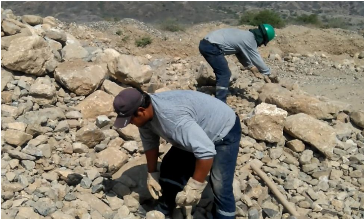
Labores de selección y fragmentación de roca para chancado y piedra base en el sector Picapedrero en la cantera Pátapo La Victoria S.A.
