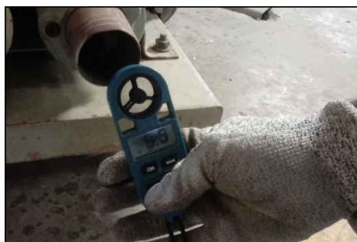
Figura 31: Medición de flujo de aire.
