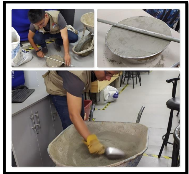
Foto 09: Uniformización de las proporciones de agregado fino y cemento para comenzar la mezcla.
