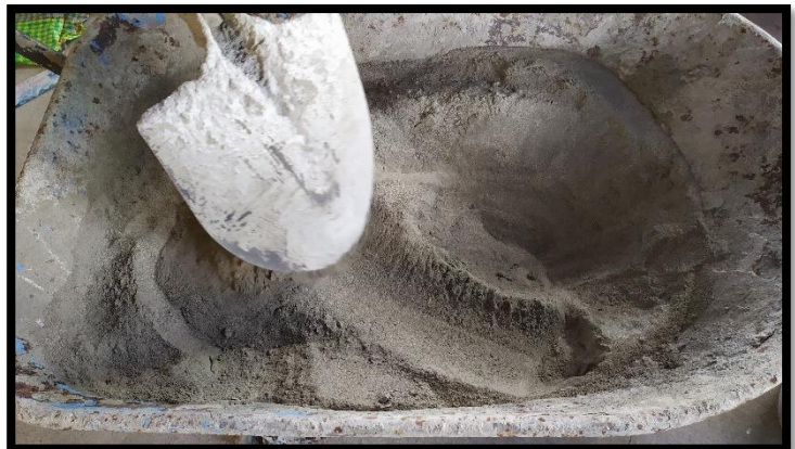
Foto 21: Mezcla del mortero sin hidratar.
