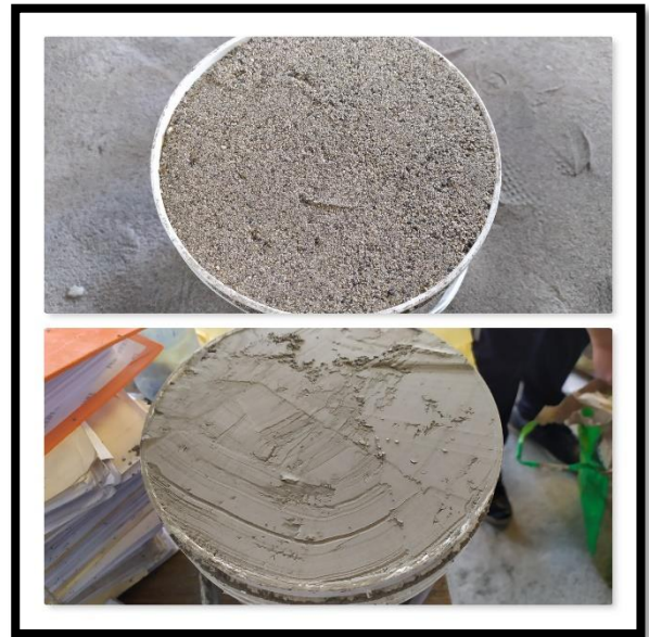
Foto 20: Uniformizando proporciones de arena y cemento para el mortero.
