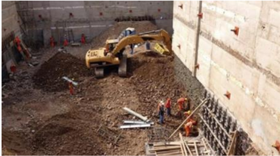
Figura 12. Proceso constructivo del muro anclado.
