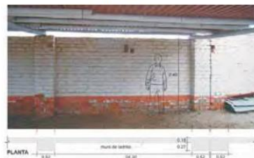
>>Fig 7.3 Colapso, desde su base, de un cerco de ladrillos con mochetas del mismo material, orientado paralelamente a la línea costera. San Andrés, Pisco, 15.08.2007. Ubicación en F-5.2.
