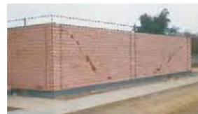
>>Fig 7.5 Si los muros perpendiculares, como se aprecia en este caso, o las columnas están demasiado separadas, los daños se producirán por la inestabilidad de su parte central. Foto: Sunampe, Chíncha, 15/08/07.
