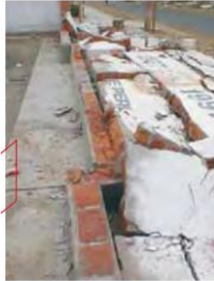
>>Fig 7.3 Colapso, desde su base, de un cerco de ladrillos con mochetas del mismo material, orientado paralelamente a la línea costera. San Andrés, Pisco, 15.08.2007. Ubicación en F-5.2.
