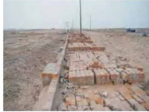
>>Fig 7.5 Si los muros perpendiculares, como se aprecia en este caso, o las columnas están demasiado separadas, los daños se producirán por la inestabilidad de su parte central. Foto: Sunampe, Chíncha, 15/08/07.
