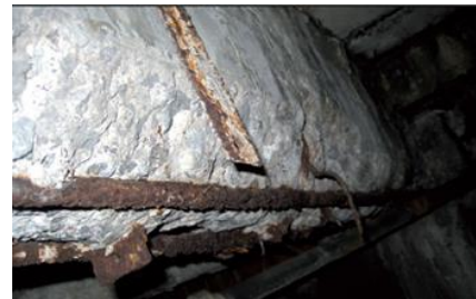
Corrosión de armaduras, Monroy (2007)
