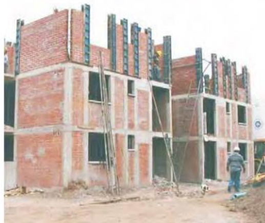
>> F-2.1b Albañilería confinada en proceso constructivo.
