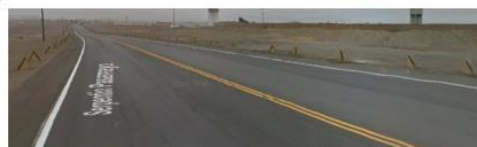
TRAMO DE ANCON DEL SERPENTIN DE PASAMAYO
