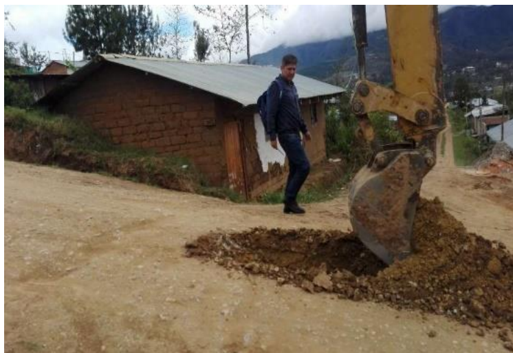
Excavación de terreno para calicata, con la maquinaria pesada
