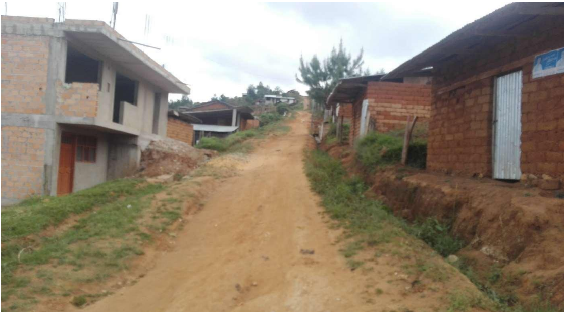
Aquí se aprecia las casa que no cuenta con agua y tiene una pendiente
