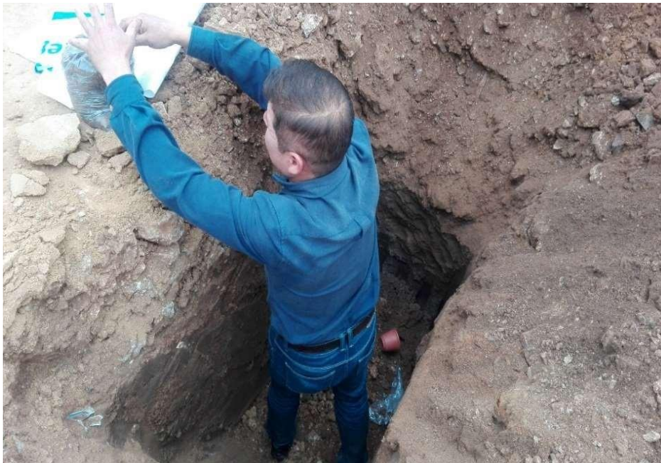
Extrayendo el material de la calicata para muestras
