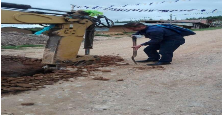
Iniciando los trabajos de excavación de calicata con maquinaria
