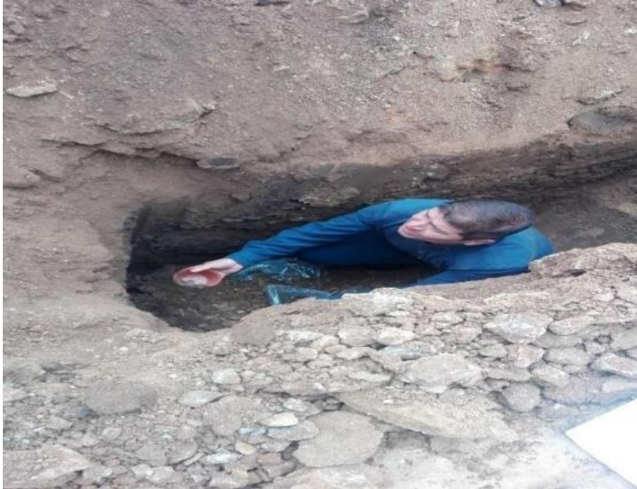
Se está sacando el material realizando excavación con maquinaria pesada
