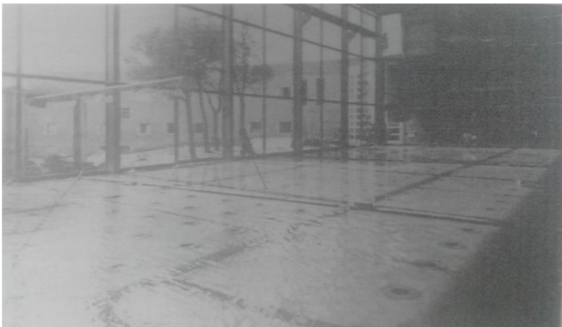
Figura 1: Curado de una Losa por inundación.
