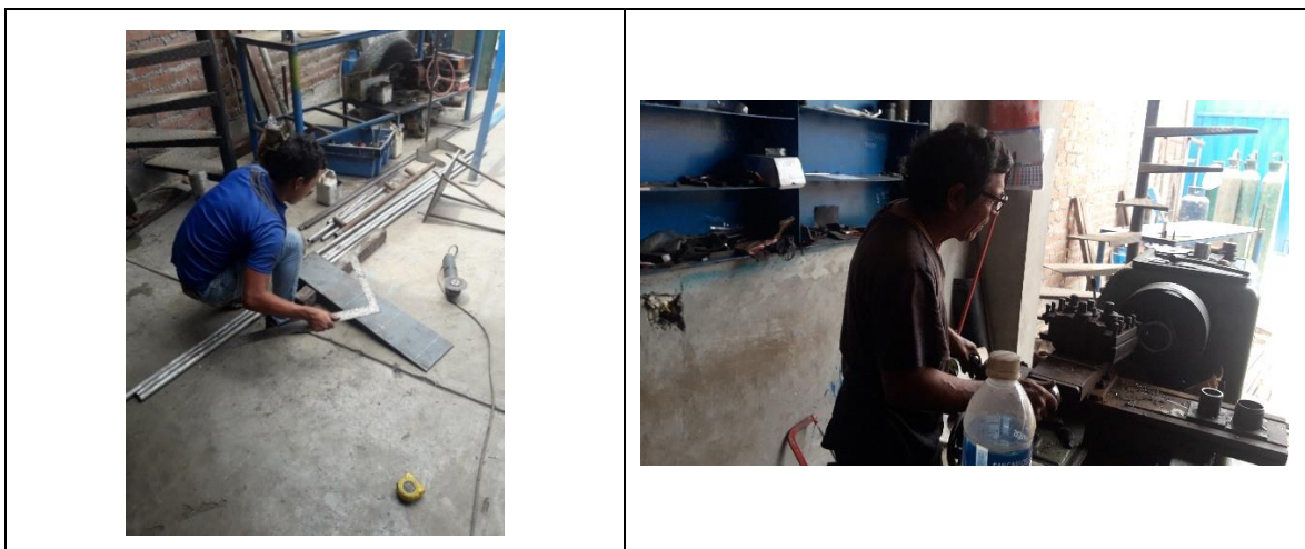
Figura 23: Falta de protección y equipos EPP, tránsito de personas no autorizadas, falta de señalización. Fuente: TRAMAR E.S.M.
