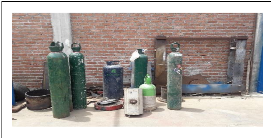
Figura 22: Gases en condición riesgosa (Oxígeno junto a propano, acetileno y expuestas al sol). Fuente: TRAMAR E.S.M.
