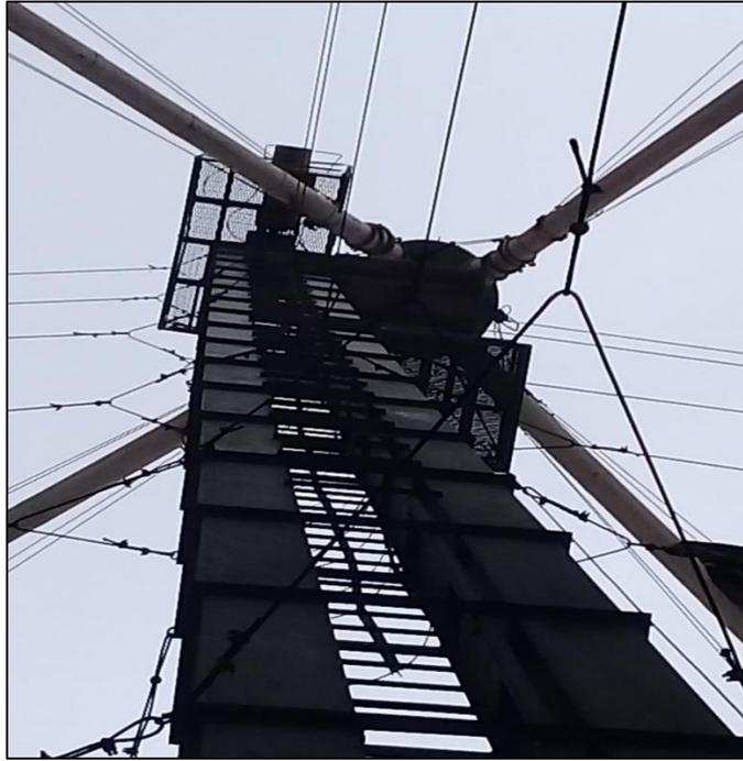
*Figura 12.* Elevador principal y ductos de distribución del trigo a los silos
