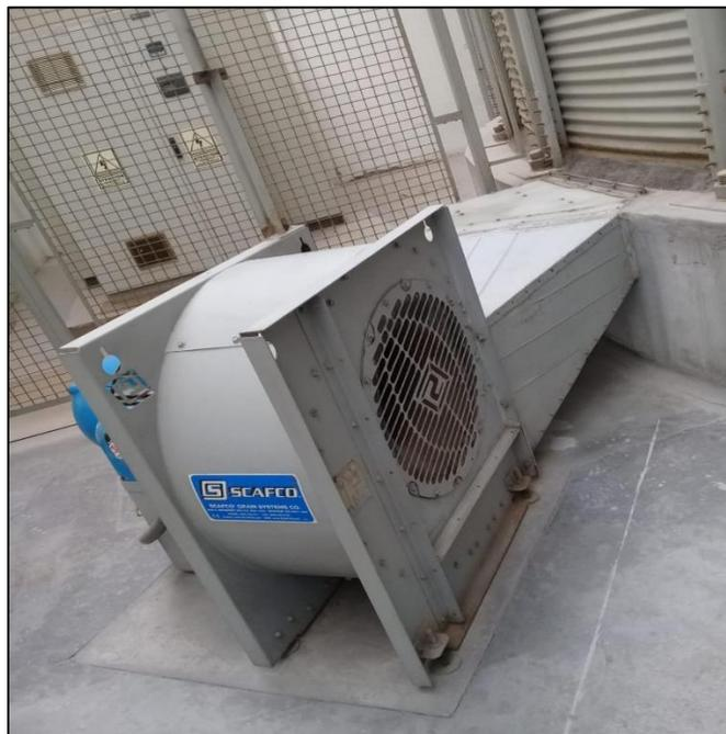
*Figura 15.* Ventiladores a los laterales de los Silos Metálicos para insuflar aire.
