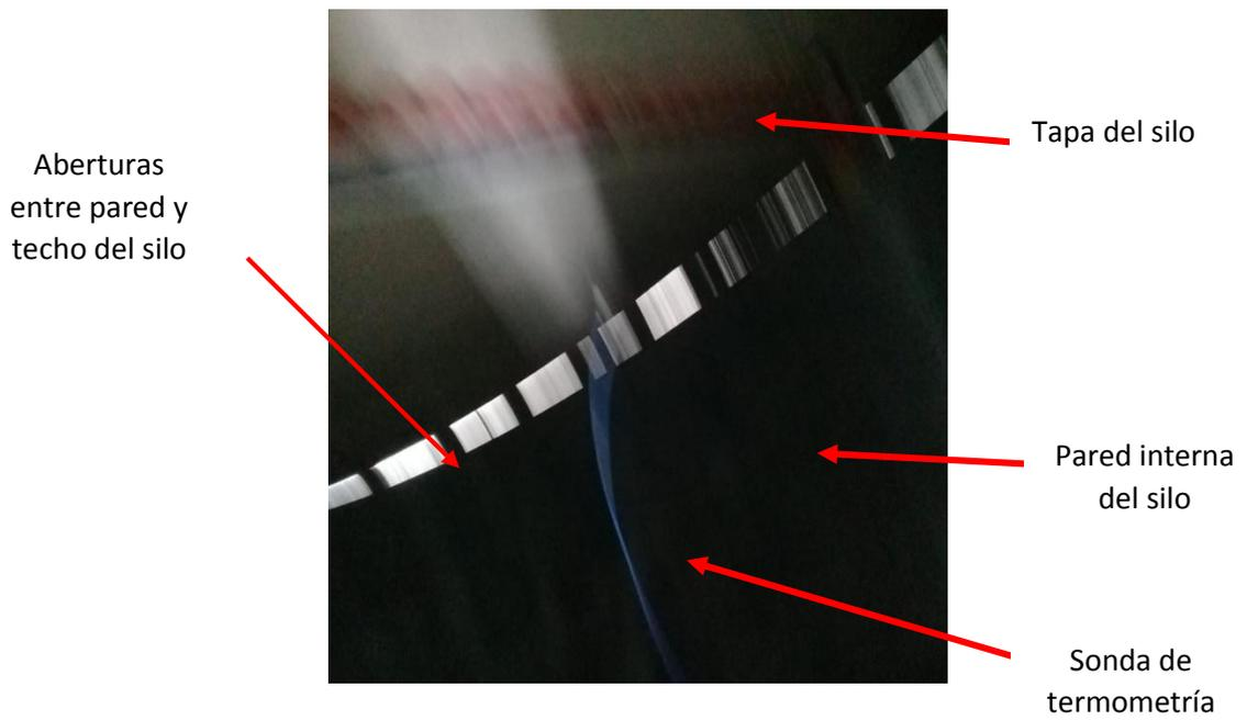
*Figura 14.* Toma fotográfica interna de la falta de hermeticidad de los silos.
