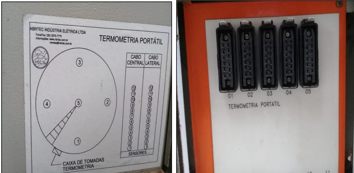
Figura 16. Sistema de Termometría portátil ubicado en los laterales de los silos
