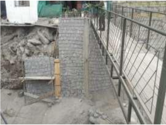
Figura 14. Muro empírico construido por los moradores de la zona
