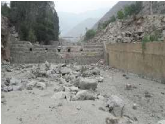
Figura 8-1. Barreras para la protección de huayco , Elaboración propia.
