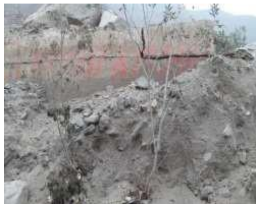
Figura 11. Estado actual de los muros
