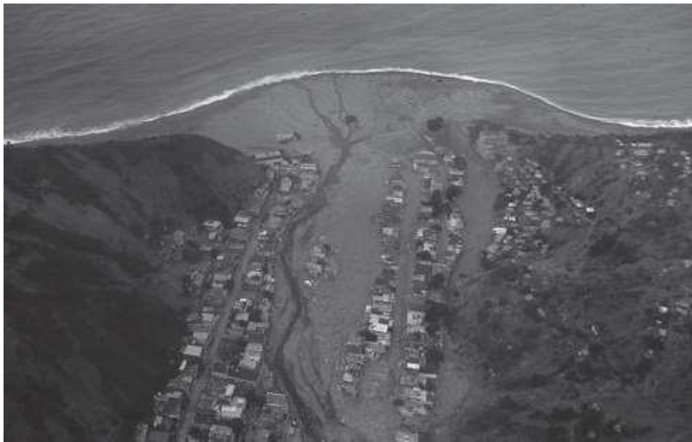
Figura 3-8 Flujo de lodos que destruyó la ciudad de Carmen de Uría en el estado de Vargas, Venezuela en diciembre de 1999. Fuente: Deslizamientos. Juárez (2015).
