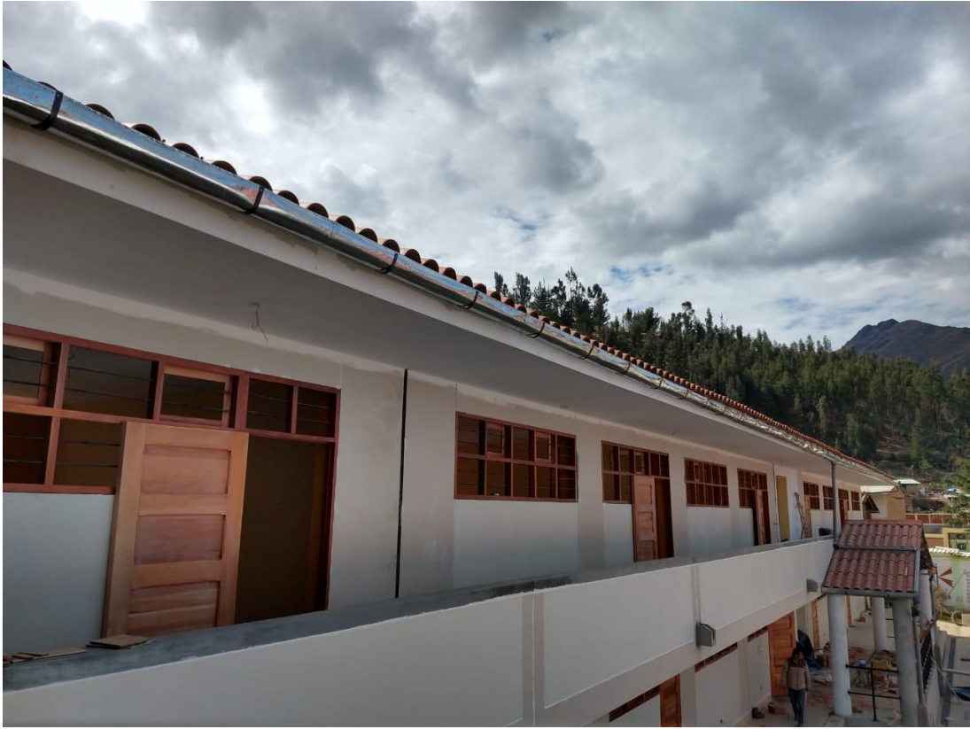
Avance de obra al 90%, Cabana – Ancash
