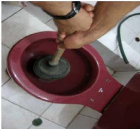
Figura 1-5 – Mantenimiento en caso de atoro
