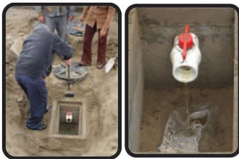
Figura 1-17 – Procedimiento en caso de obstrucción de lodos
