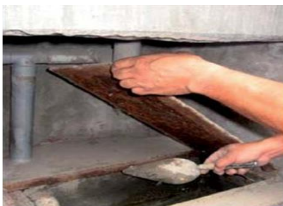
Figura 1-8 – Mantenimiento correctivo de la caja de registro
