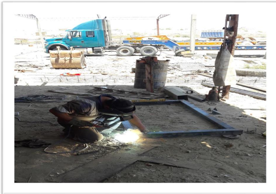
Personal realizando el soldado de la estructura principal del perforador semi industrial.
