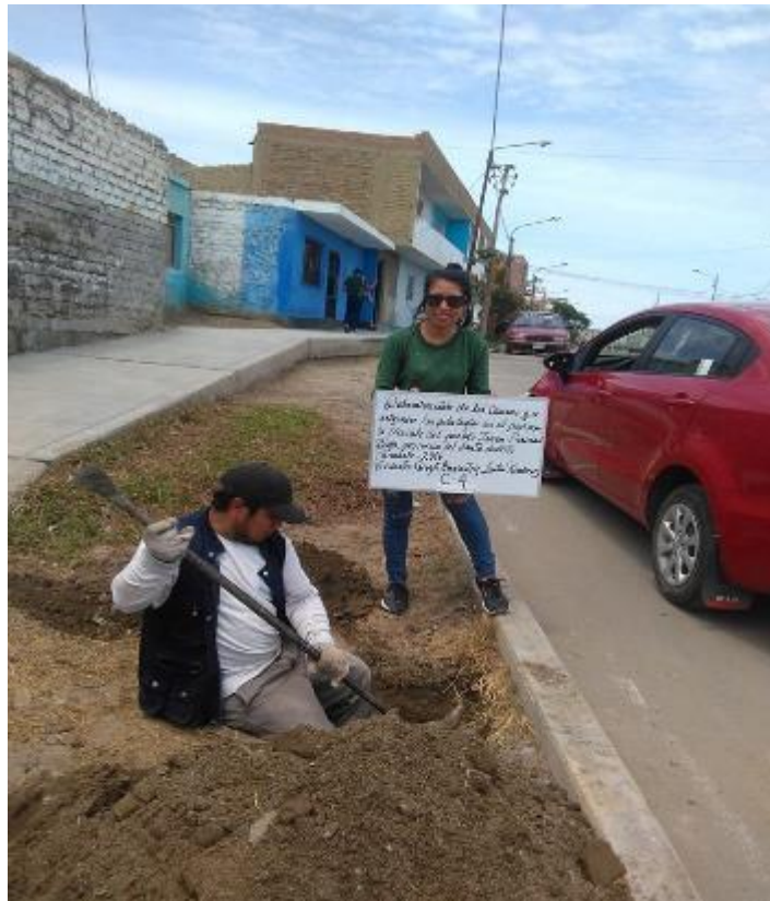
FOTO N° 8: Excavación de la calicata de la progresiva 1+000
