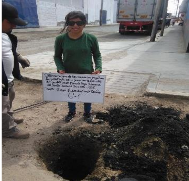
FOTOS N° 1: Excavación de calicatas en la progresiva 0+250
