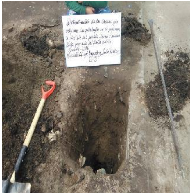
FOTO N° 7: Se aprecia diferentes tipos de muestra para los ensayos granulométricos
