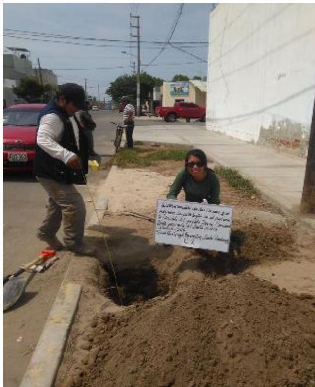
FOTO N° 4: Excavación de la calicata en la progresiva 0+500
