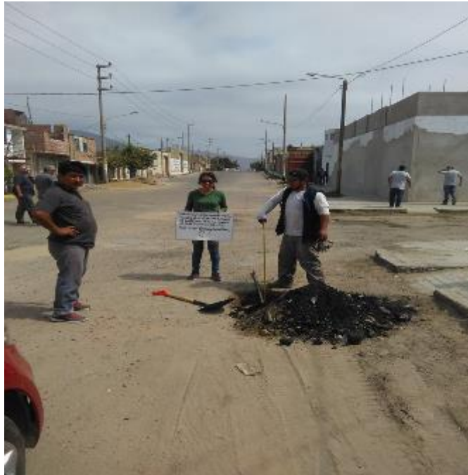
FOTO N° 3: Material altamente orgánico de olor fétido
