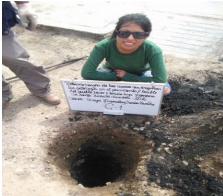
FOTO N°2: Nivel freático se contro en los - 1.10 m de profundidad
