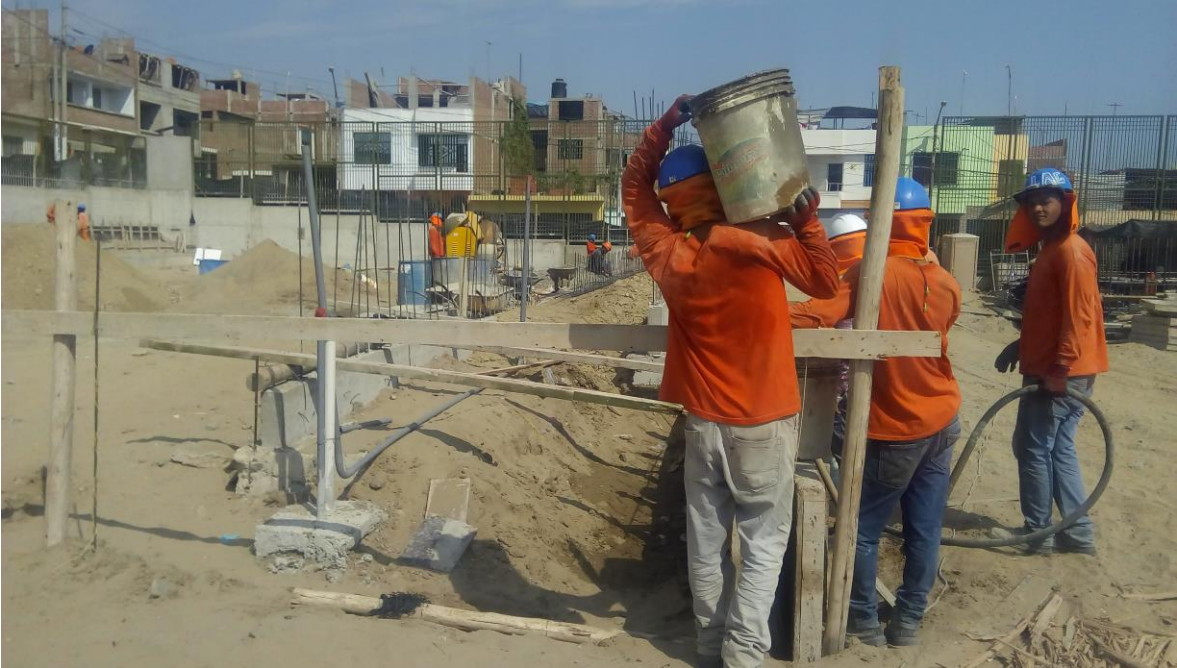
Trabajadores de la constructora en trabajo de obra
