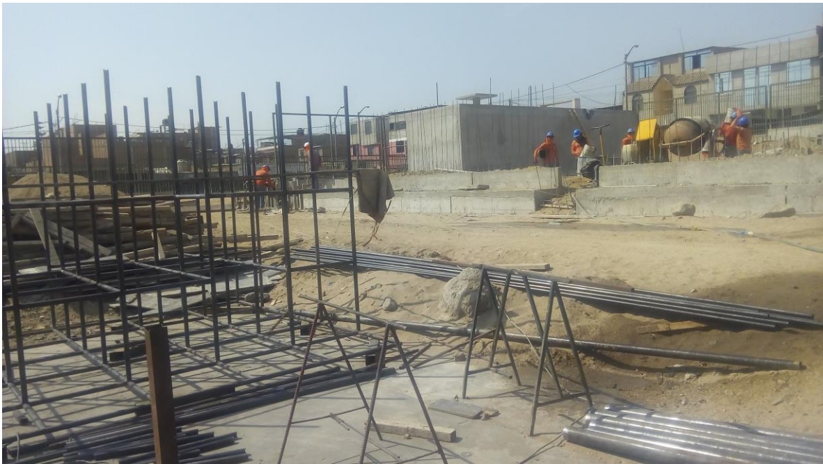
Materiales de trabajo en obra
