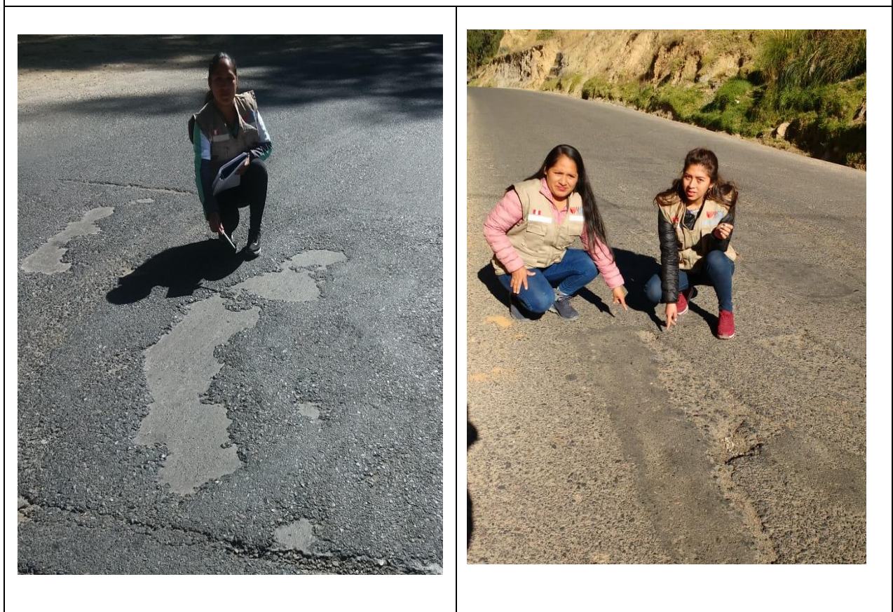
Figura N°05. Inspección del tramo de estudio
