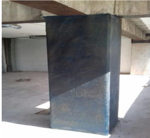
Figura 2: Reforzamiento de la columna por encamisado de Fibra de Carbono.
