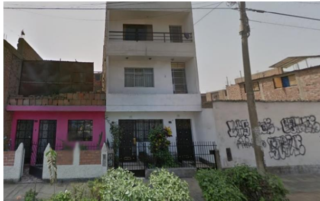
Figura 16. Vivienda de 3 pisos a realizarse el reforzamiento de la fibra de carbono. (calle micaela bastidas #385)
