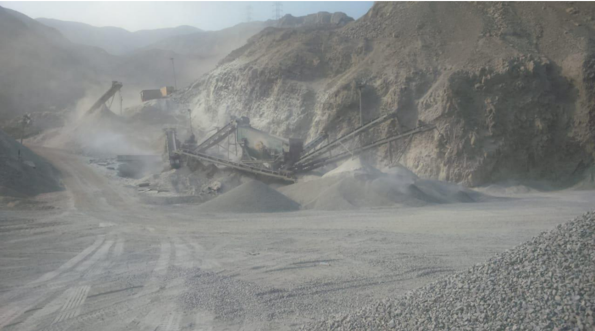
Figura N° 9 Centro de triturado de los agregados.
