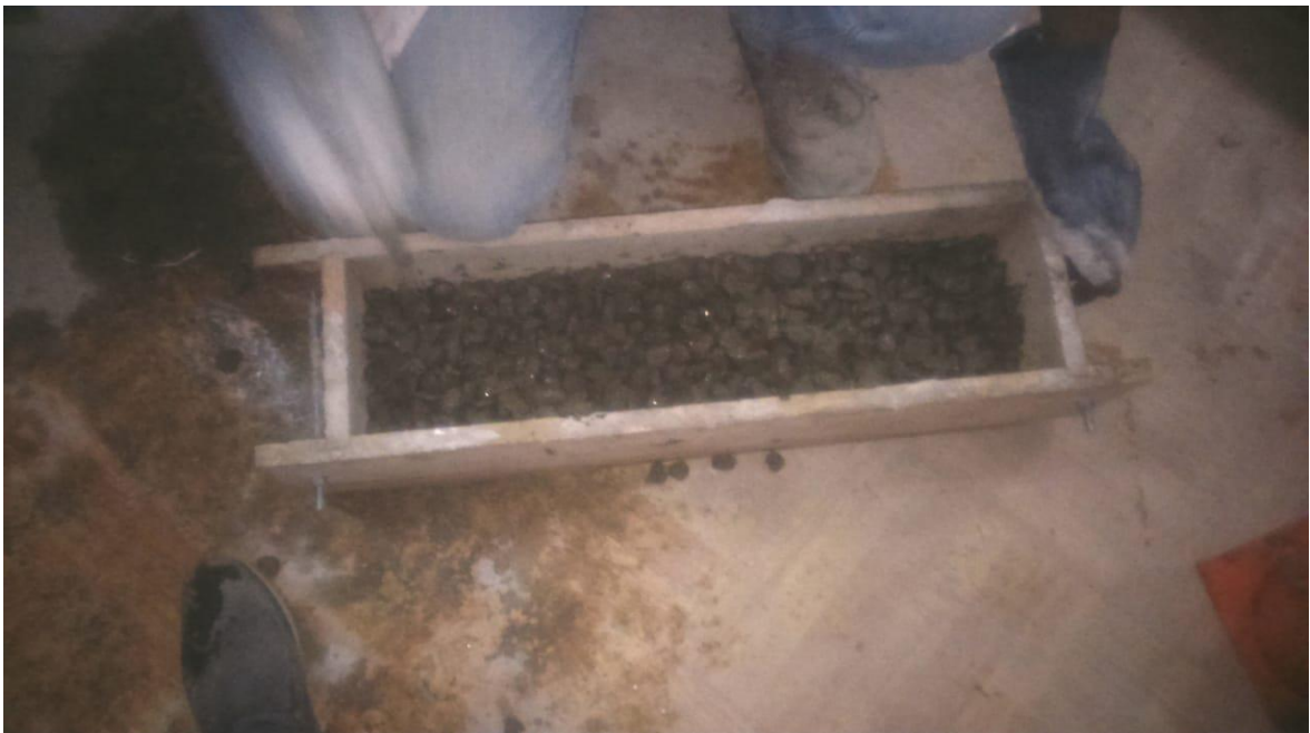
Figura N° 39 Llenado de vigas y compactado.
