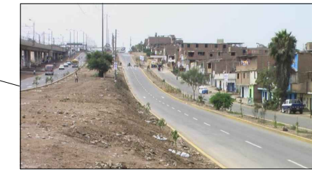
AVENIDA SEPARADORA INDUSTRIAL
