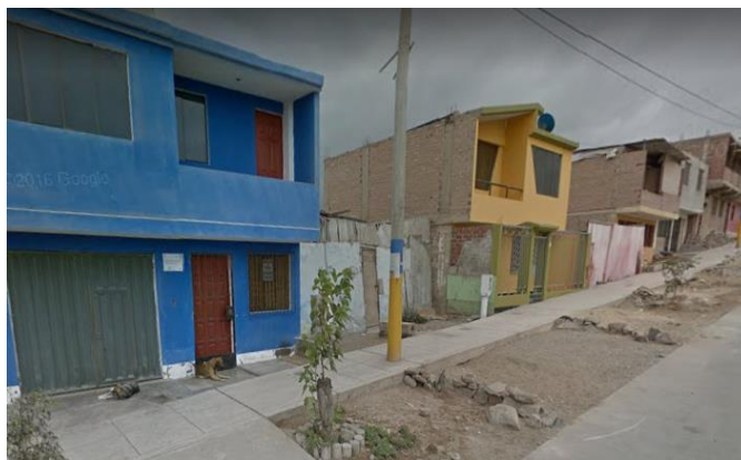
Figura 165: Viviendas en la Av. Juan Velasco Alvarado.
