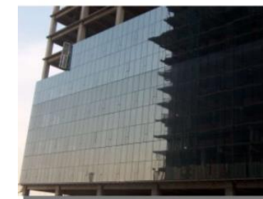
1.- IZADO DE MODULOS
