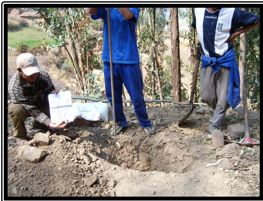
FOTO N° 04 excavación de calicatas para análisis de suelo.
