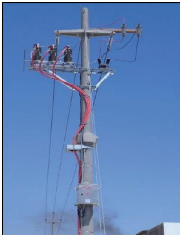
Figura 33. Vista de montaje en campo de interruptor de potencia. (HEAG, 2019)
