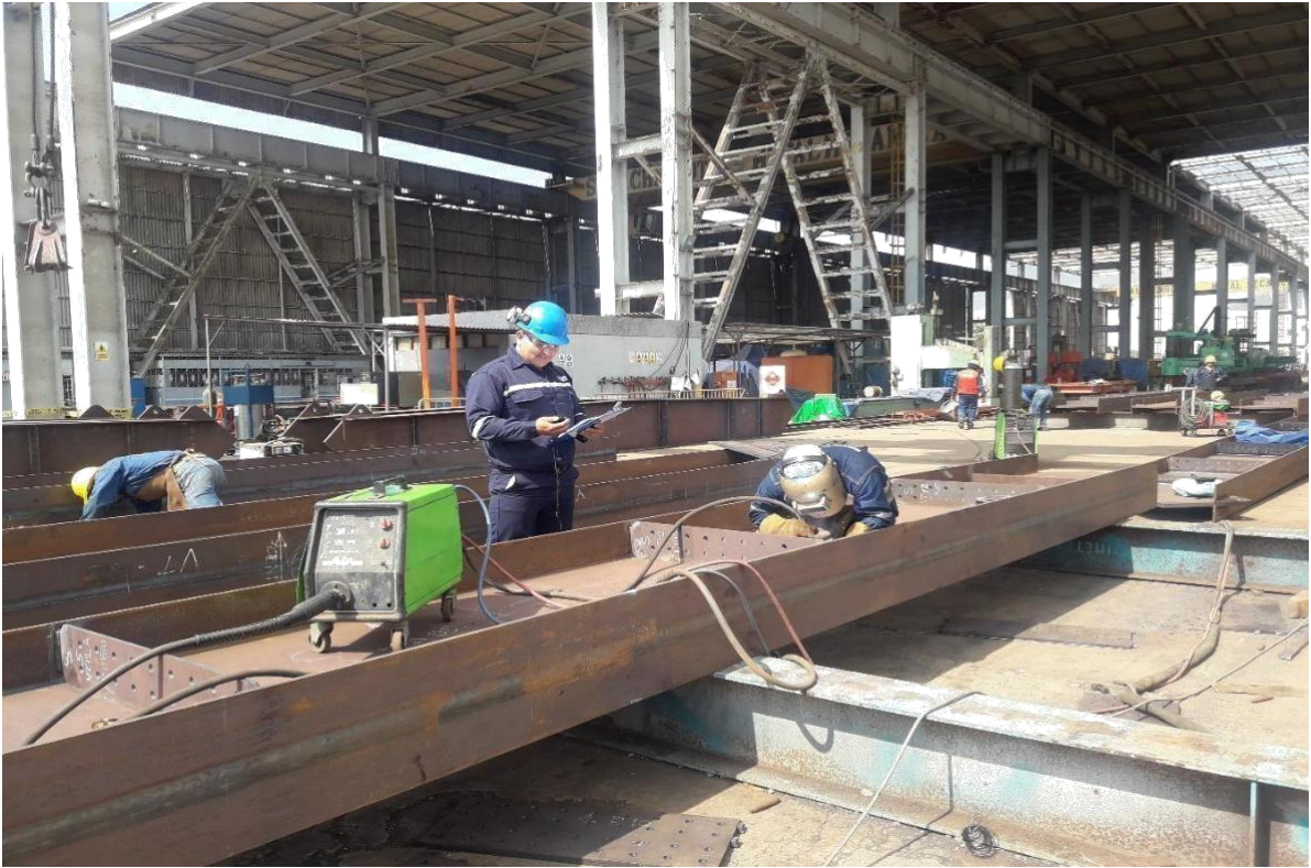
Figura 21: Toma de datos, act. del relleno y acabado del cordón, viga principal de 7 mt long.
