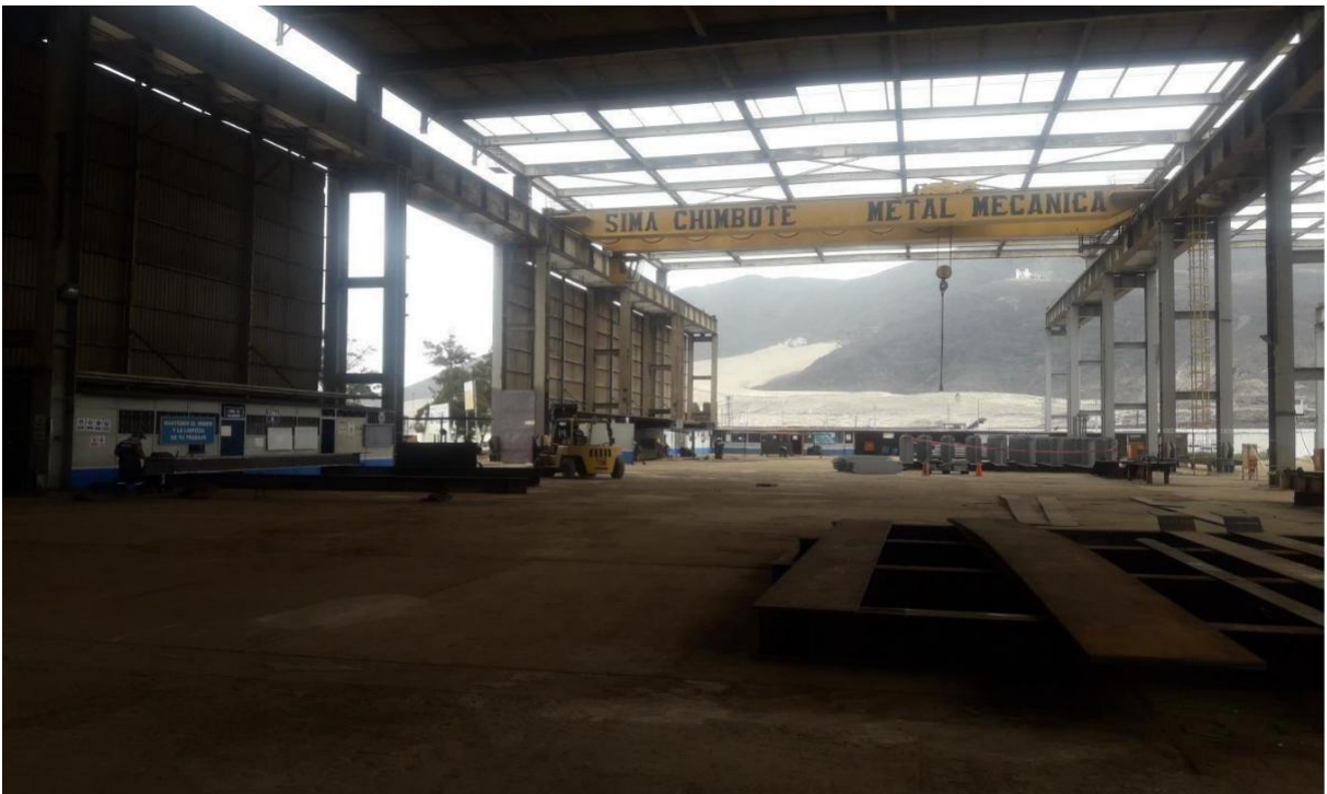
Figura 22: Zona de trabajo taller de soldadura - nave de 30 mt.
