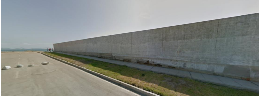
Figura 87: Fotografía 3 – Vista del terreno desde El Jirón Unión equina con el malecón.
