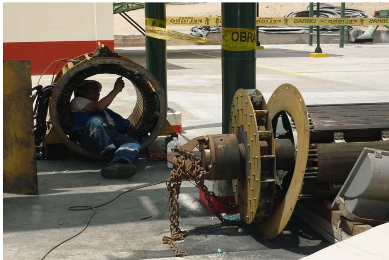
Figura 47. Mantenimiento de estator de motor de Secador Rotadisk.
