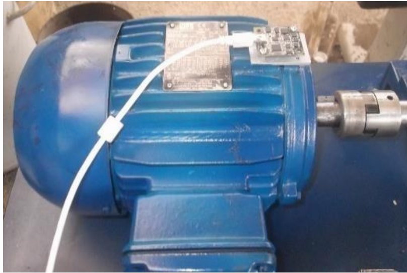
Figura 52. Alineamiento de eje de estator con transmisión de ventilador centrífugo.
