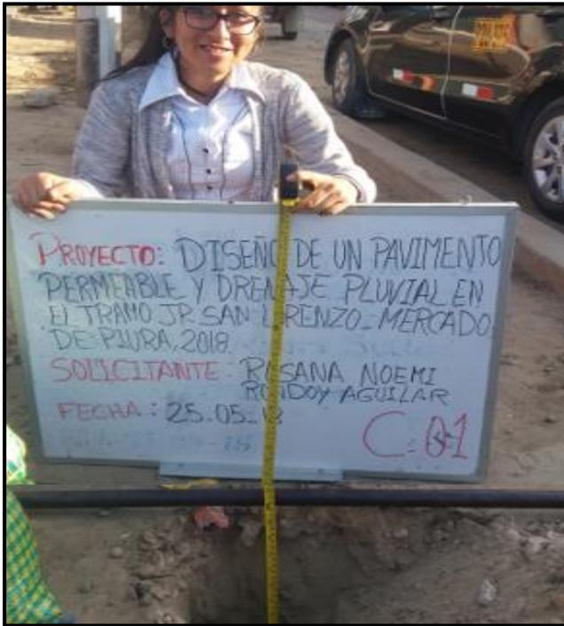
En la presente fotografía se muestra la excavación de la calicata 01 realizado de acuerdo a las indicaciones del Manual de carretera, para la extracción de las muestras y llevarlas a laboratorio para la aplicación de los ensayos
