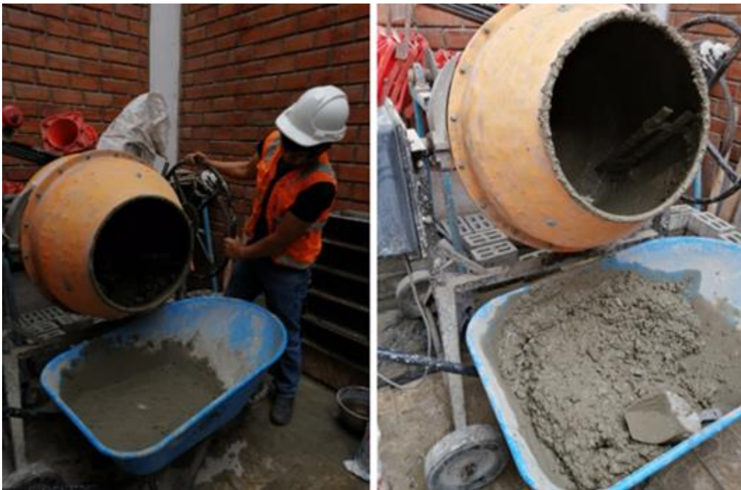
Mezclado del concreto
