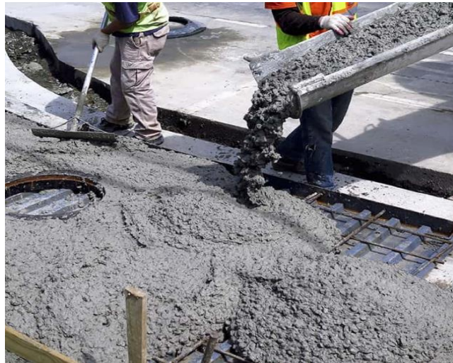
Figura 7: Imagen de concreto
