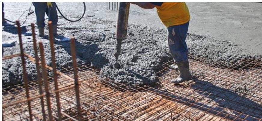
Figura 8: Imagen de concreto armado
