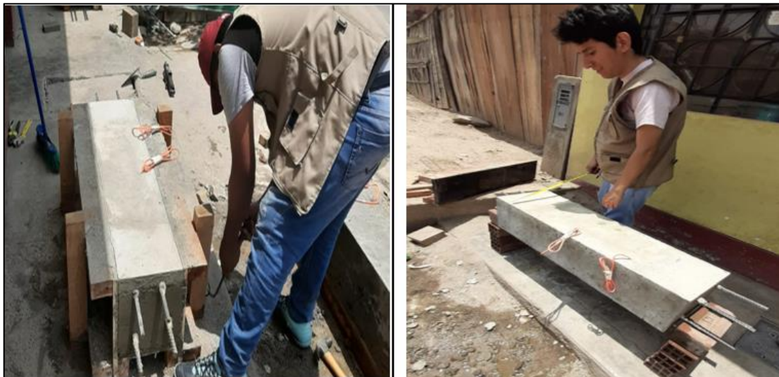
Figura 77. Desencofrado de la viga patrón + 1% de aditivo acelerante
