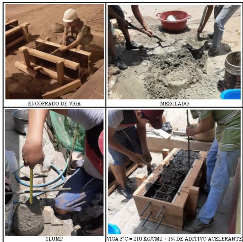
Figura 55. Elaboración de la viga patrón +1% Aditivo acelerante Fuente: Elaboración propia
