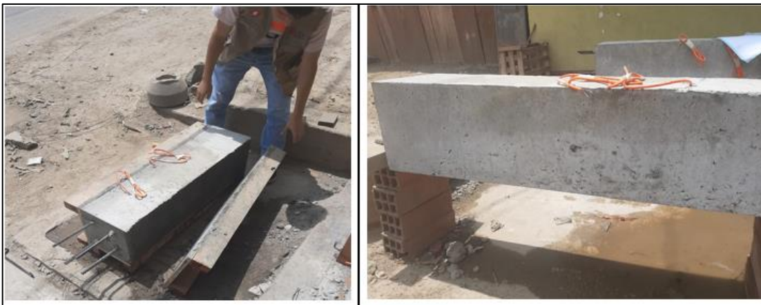
Figura 76. Desencofrado de la viga patrón
