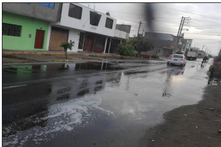
Se puede observar el agua de lluvia almacenada en el pavimento flexible, producto del fenómeno del niño costero, lo cual puede generar focos infecciosos para los moradores de dicha zona y deterioro de las capas del pavimento.
