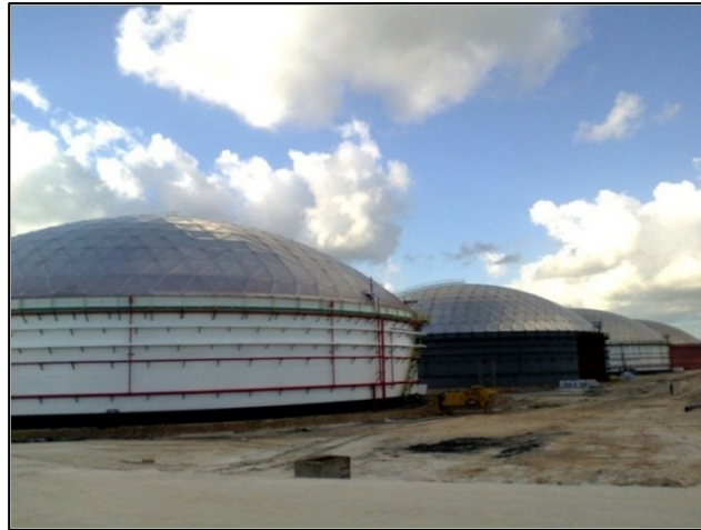
Figura 5, Tanque vertical con techo esférico fijo. (ceazul, 2013)
