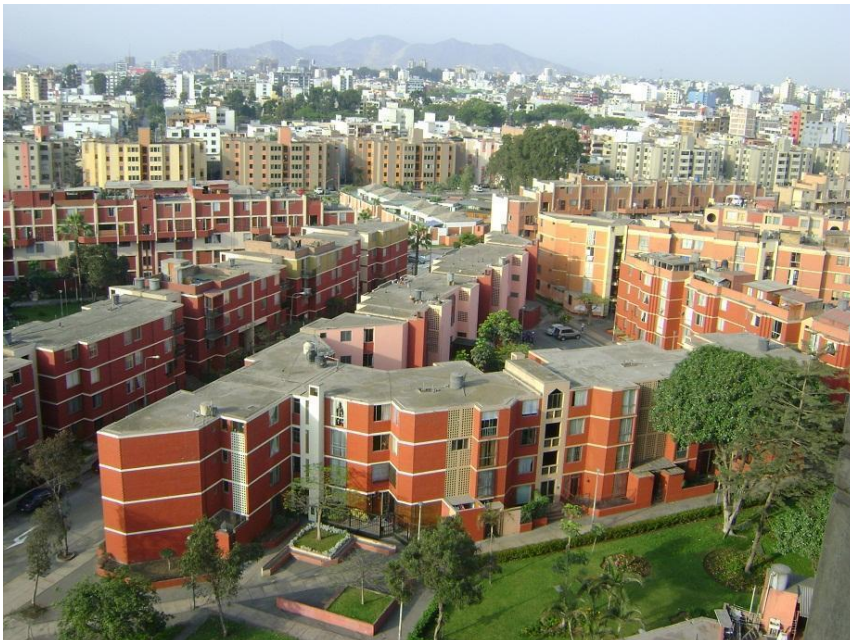
Figura 9. Vista del conjunto Habitacional Limatambo.
