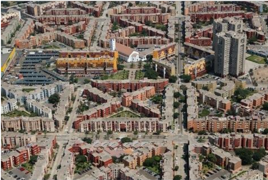
Figura 8. Vista aérea del conjunto Habitacional Limatambo.
