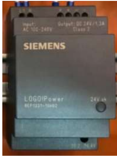
Figura 40. Fuente Siemens Power 24 V Fuente: Elaboración propia
