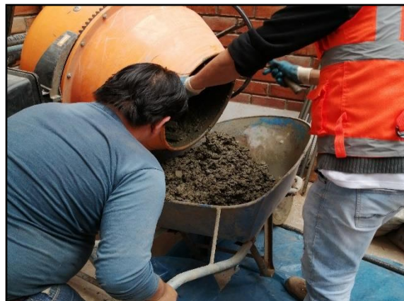
Figura 65: Vaciado de la mezcla del concreto.
