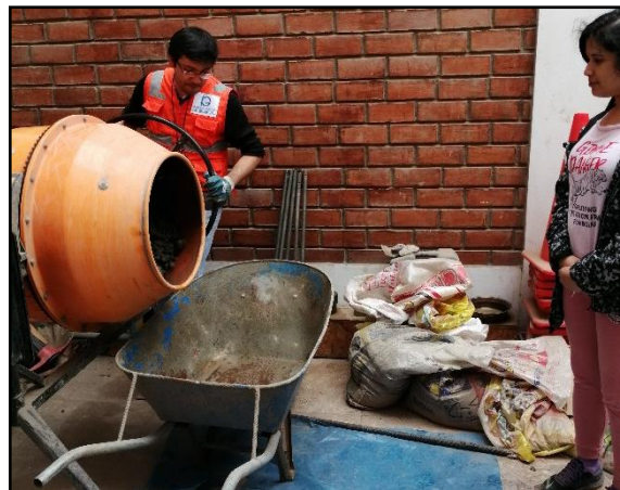
Figura 64: Inicio del vaciado de la mezcla del concreto.
