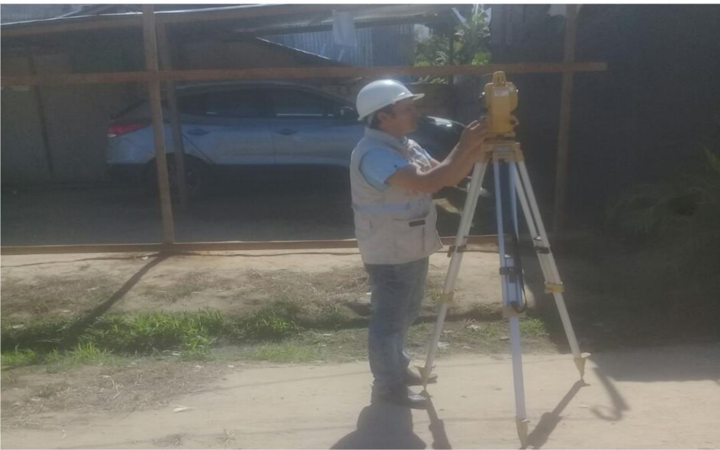
Realizando el segundo punto con estación total
