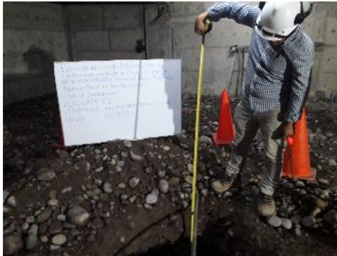
Imagen No. 7. Calicata.
