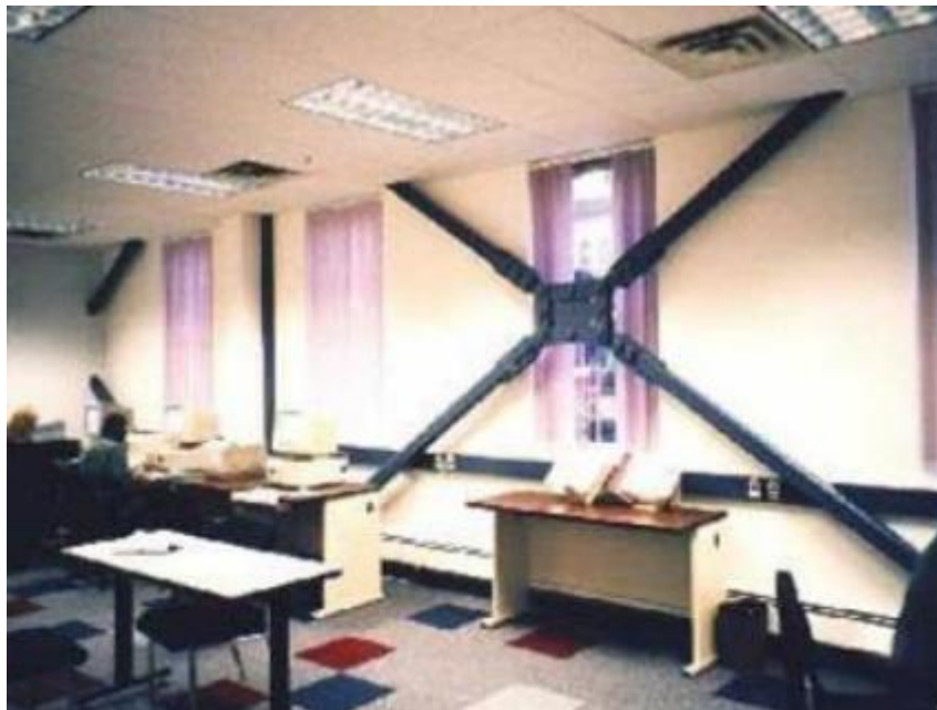
Imagen No. 03. Disipadores por fricción.
