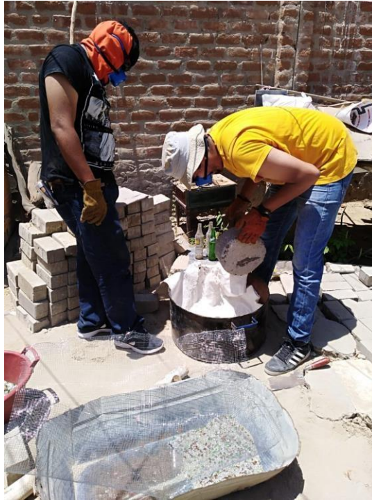
Figura 43: Se realiza la demolición de vidrio usando el equipo necesario de seguridad.
