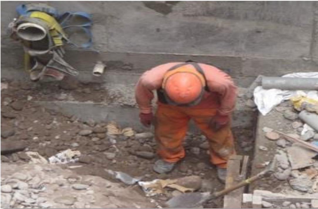
*Figura 1. EPP's deteriorados*
