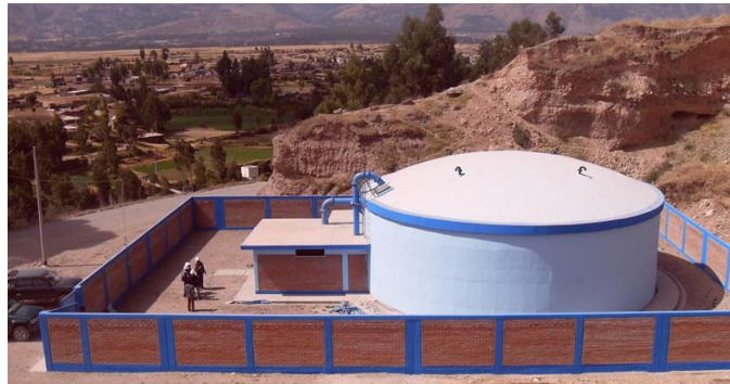
Figura 2. Reservorio Apoyado de C° A° de forma circular (Fuente: https://goo.gl/k2B7uq .)
