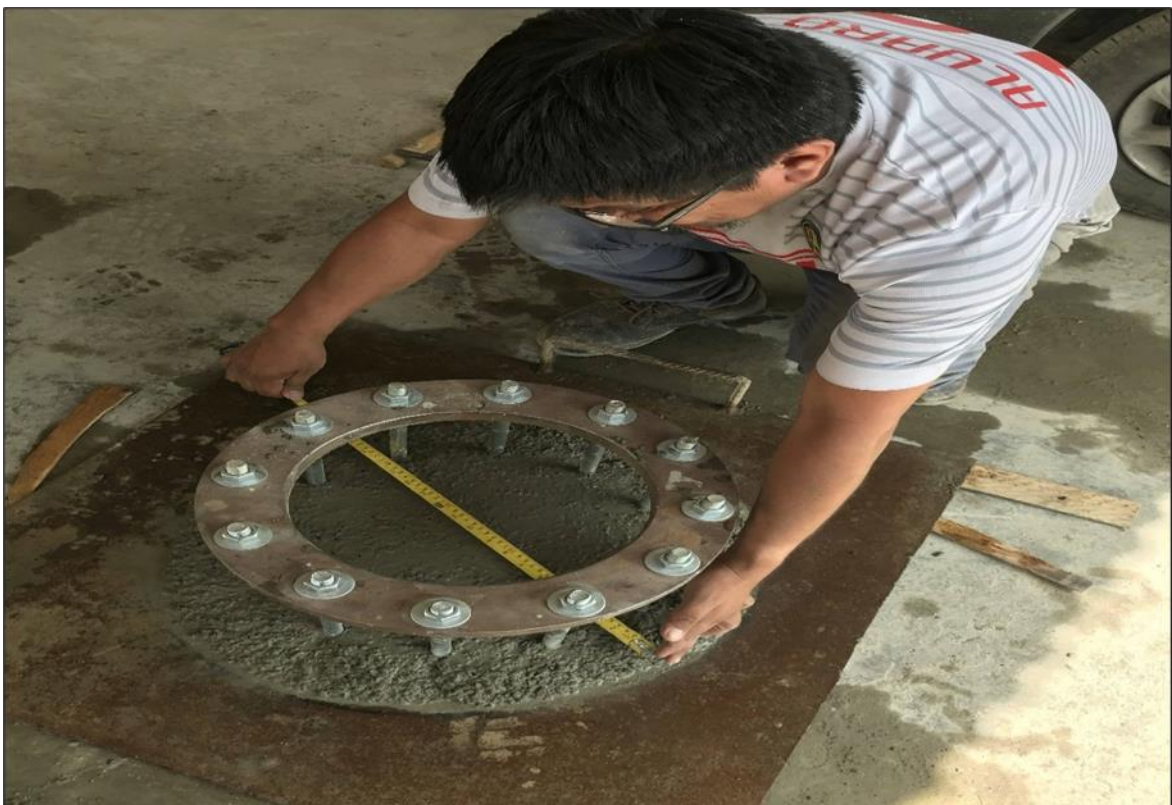
Figura 35. Midiendo la capacidad de paso
