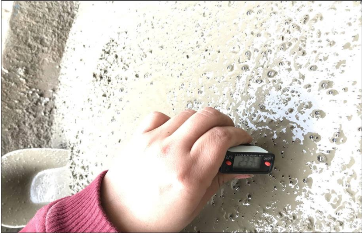
Figura 86. Tomando la temperatura del concreto
