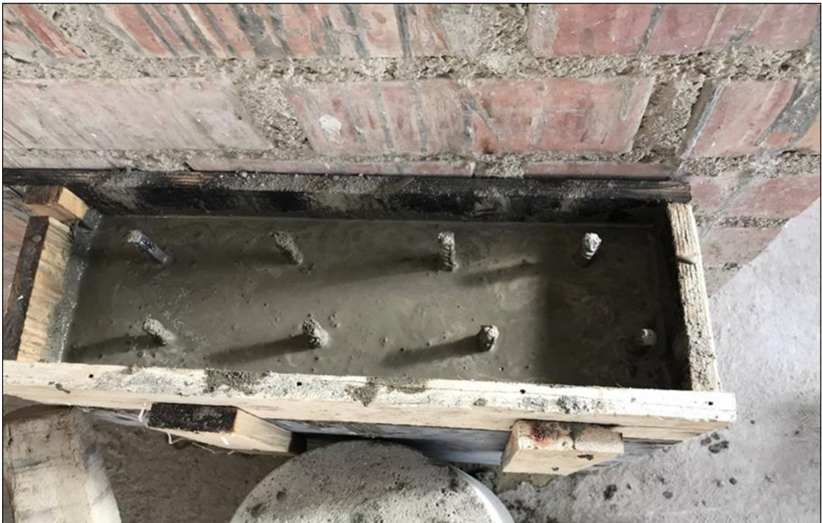
Figura 42. Llenado de placa con concreto autocompactante
