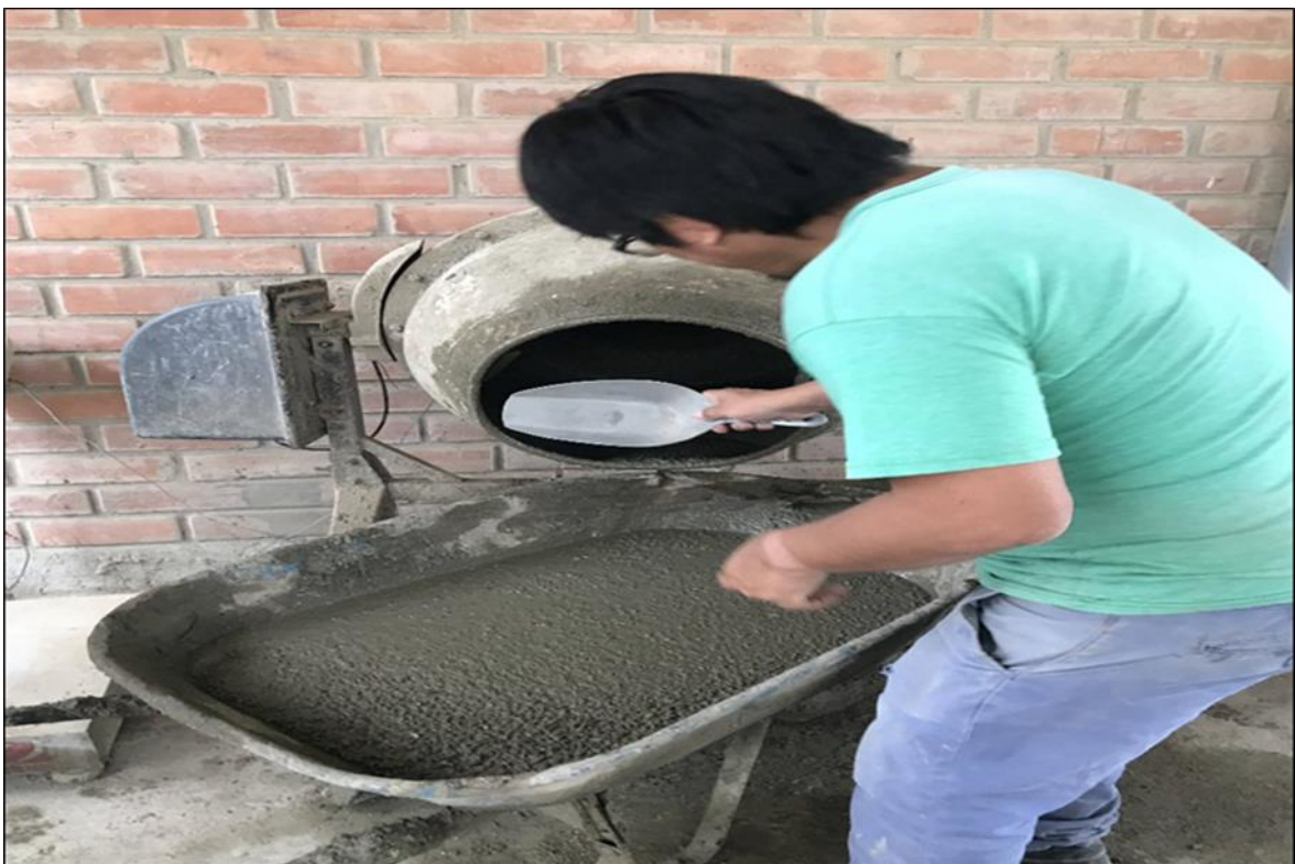
Figura 77. Sacando la mezcla en un bugui
