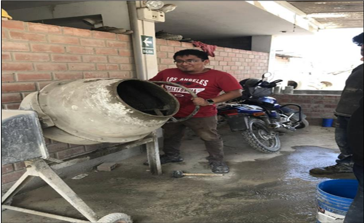
Figura 76. Preparando el diseño en la maquina mezcladora
