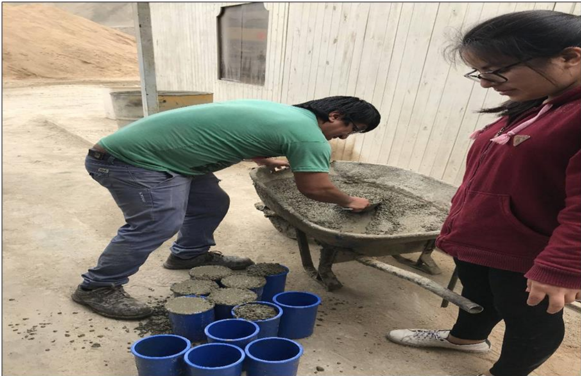
Figura 37. Preparando probetas para los especímenes de concreto
