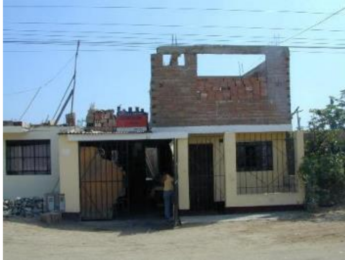
Imagen No. 10. Vivienda con muros para un futuro segundo piso.
