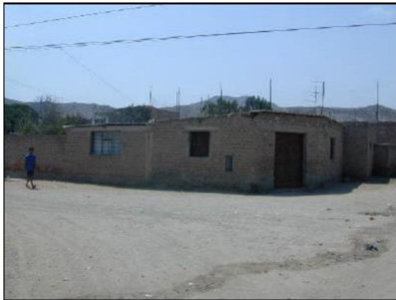
Imagen No. 6. Vivienda con techo provisional.
