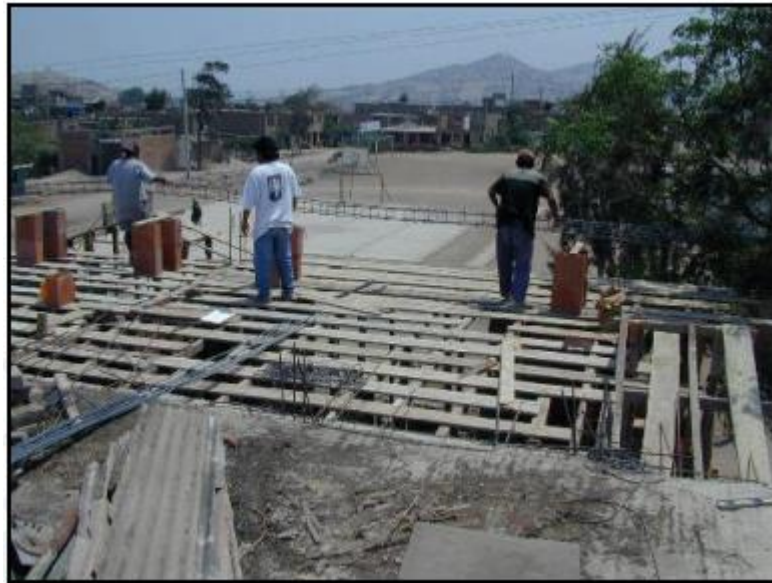
Imagen No. 7. Armado del encofrado para el techado.
