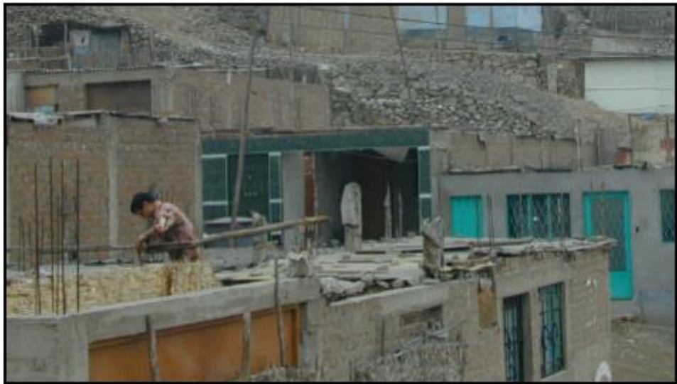
Imagen No. 5,. Colocación de la cobertura provisional sobre la vivienda.
