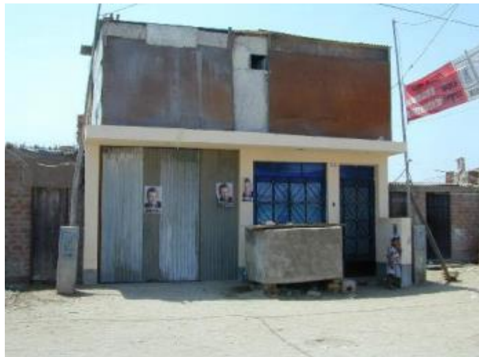
Imagen No. 9. Vivienda con tarrajeo de muros y construcciones provisionales en el segundo piso.
