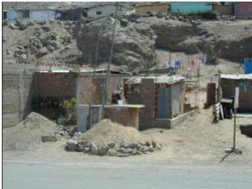
Imagen No. 4. Cimentación vaciada y levantamiento de algunos muros y columnas.
