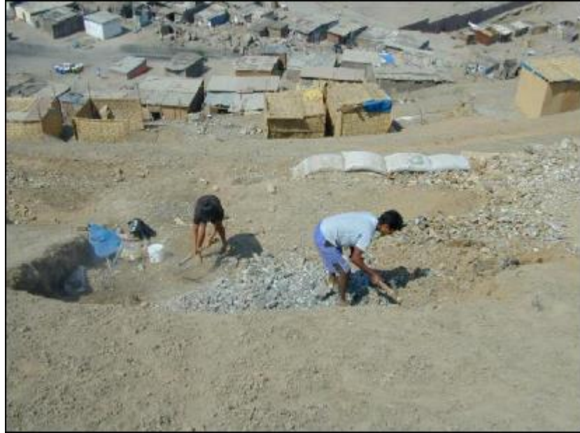
Imagen No. 2. Nivelación del terreno.
