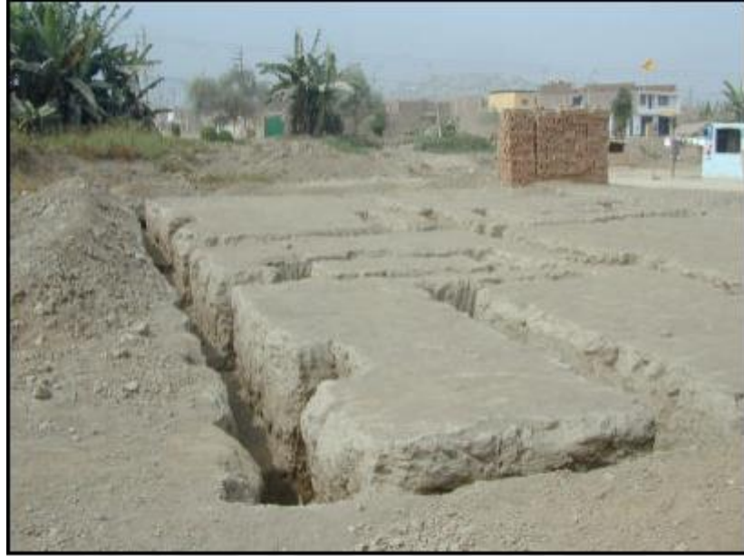
Imagen No. 3. Zanja para la cimentación.
