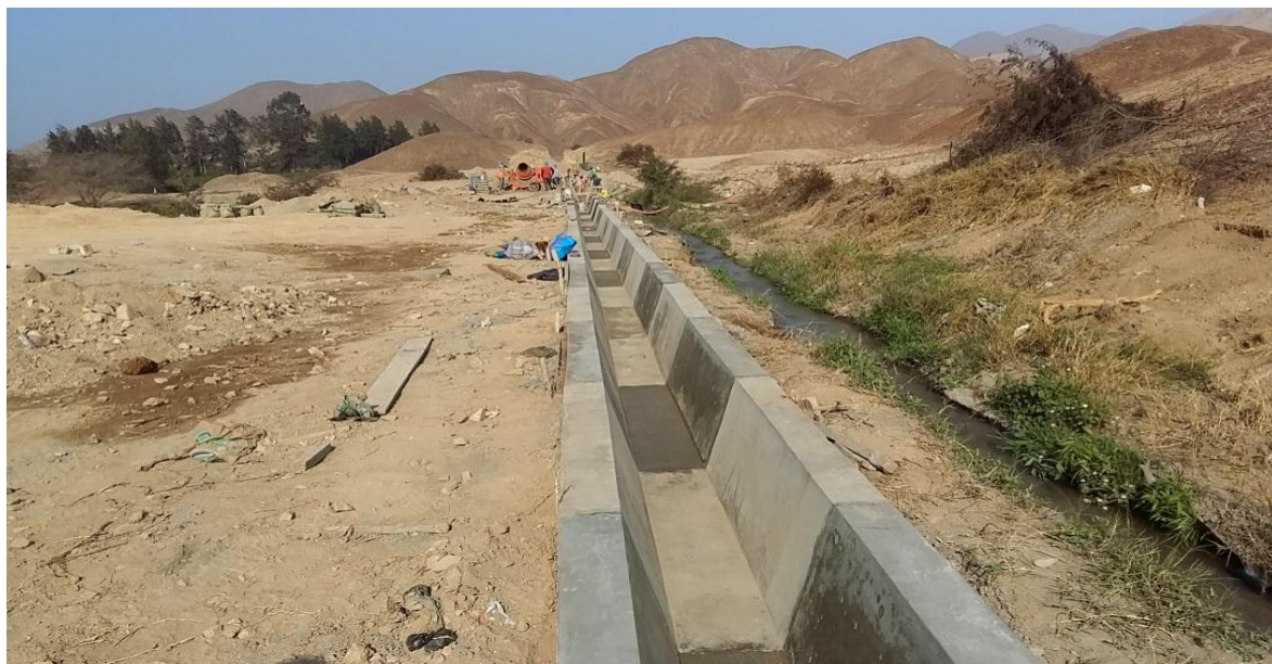
Figura N° 18: Final de la construcción del canal de riego , utilizando la fibra Arbocel en la dosificación del concreto, de acuerdo a las especificaciones técnicas
