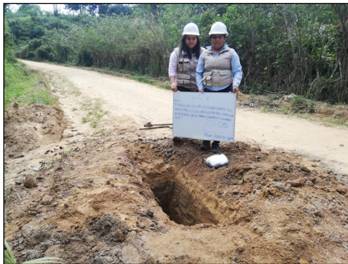
Imagen 06: Excavación de la calicata N°05 en la carretera Cacatachi – Chirapa
