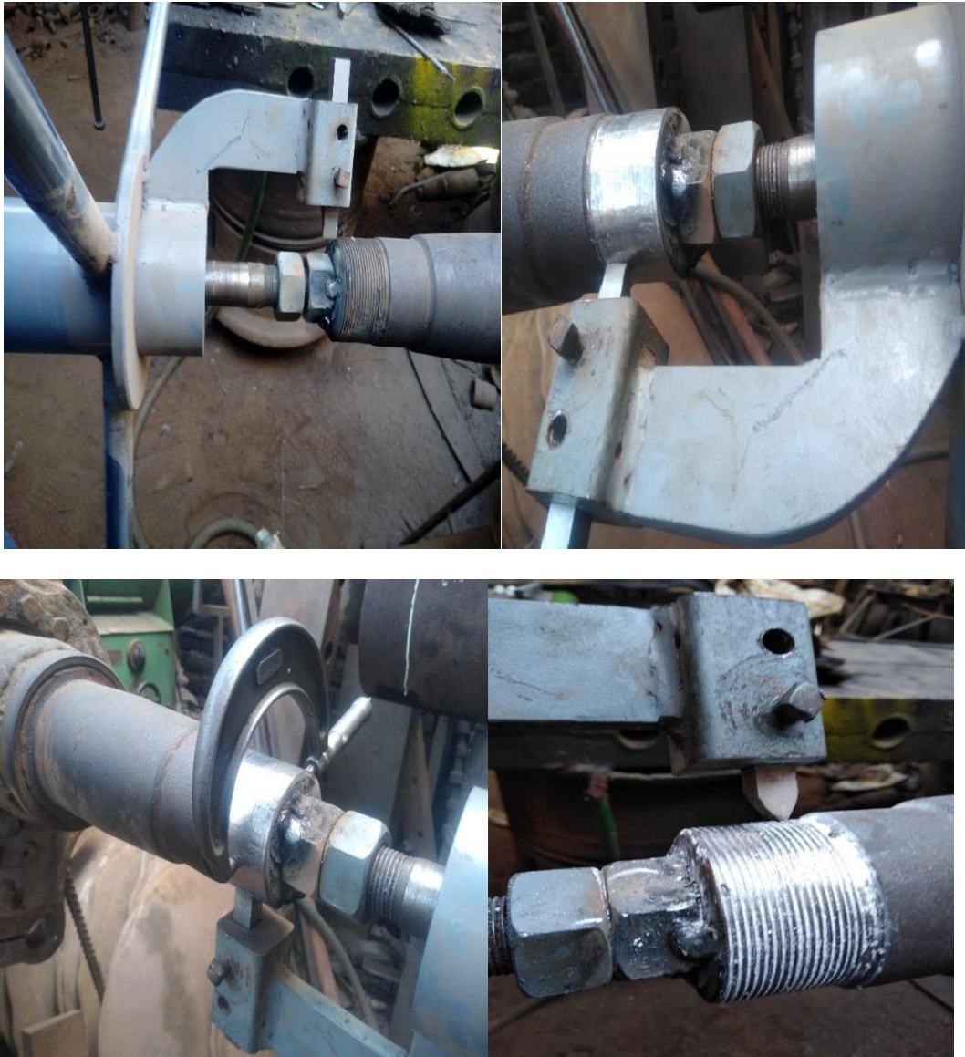
Figura N° 09 Prueba de maquina en proceso de rectificado y roscado
