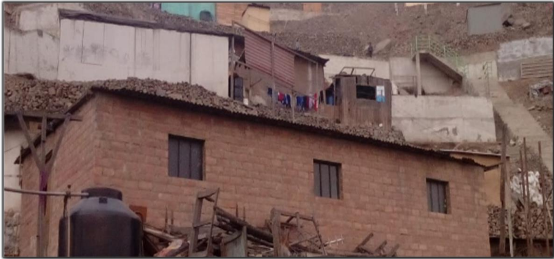
Figura 2. Edificación sin columnas
