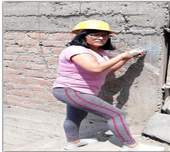
Foto N° 12: Colocación del esclerómetro en la columna del Lote N°1
