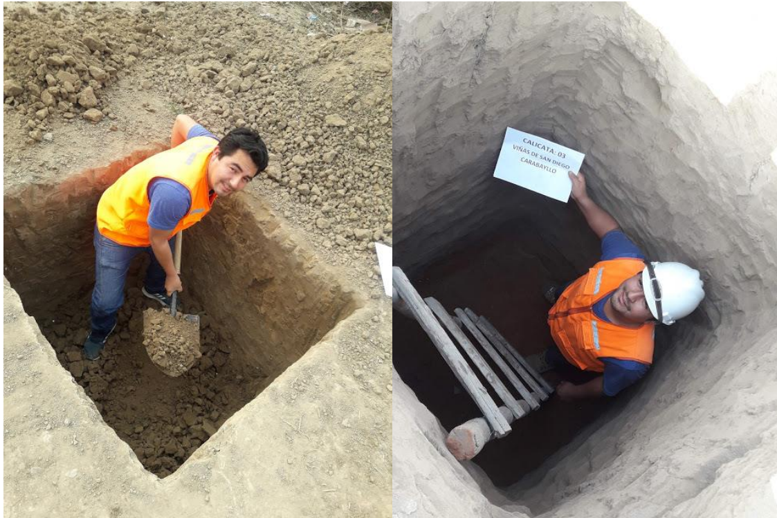
Figura 15: Excavación de Calicatas a cielo abierto
