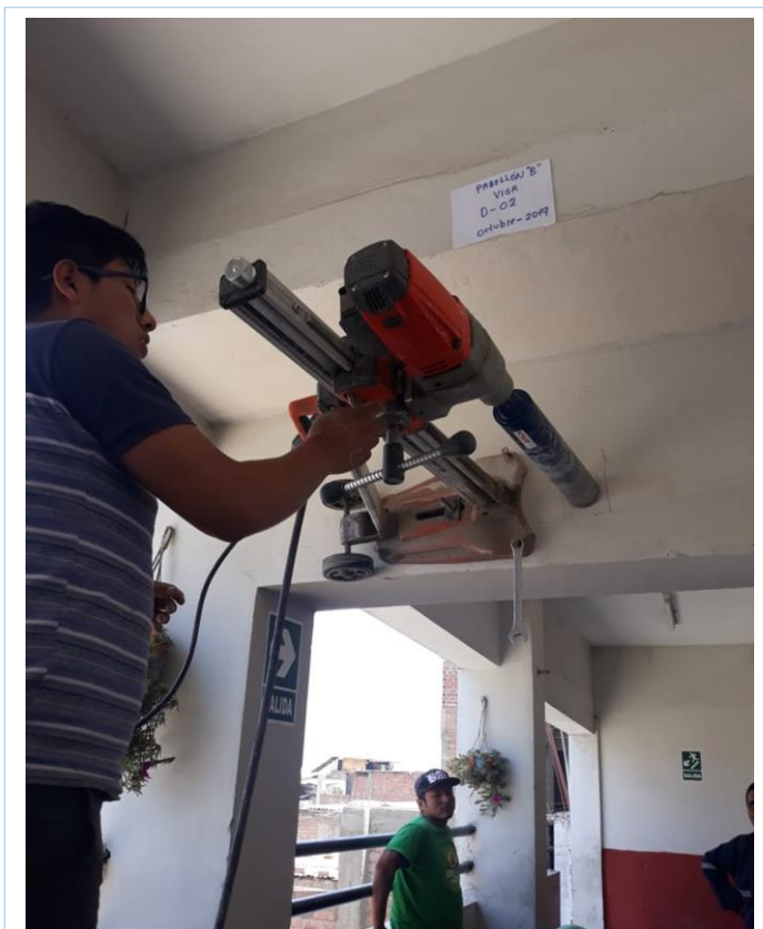
PD – 2 Viga Pabellón B
