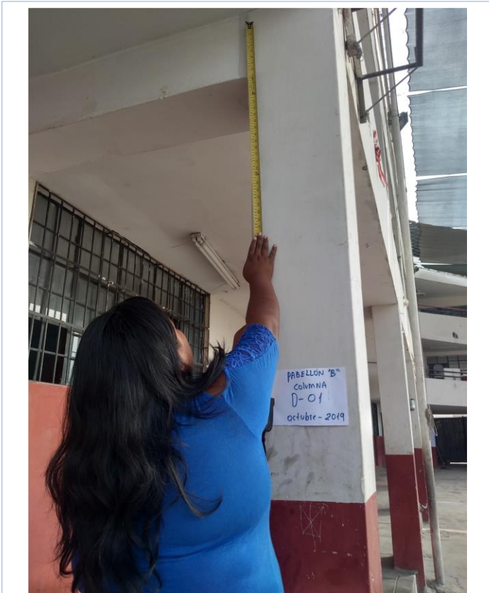
Auscultación del peralte de las vigas
