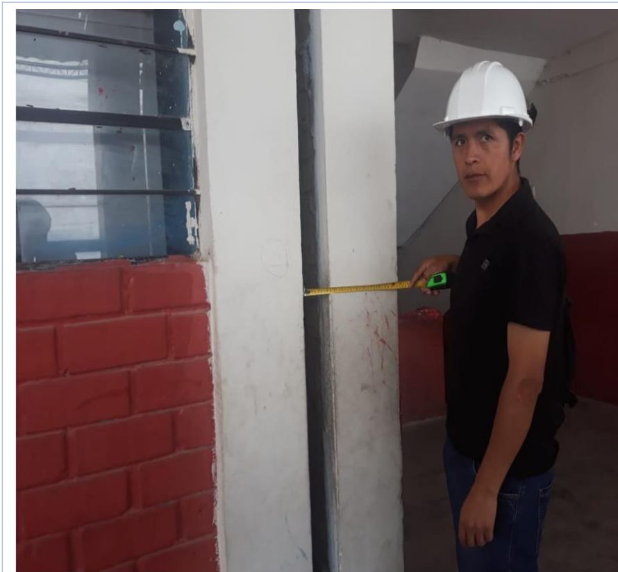
Auscultación de la junta sísmica entre pabellones A y B
