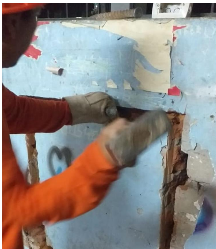
Extracción de murete de pabellón "B" de la IE 20825 – Túnez, Arroyo II
