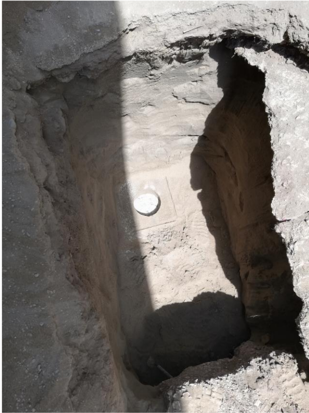
Profundidad de calicata
