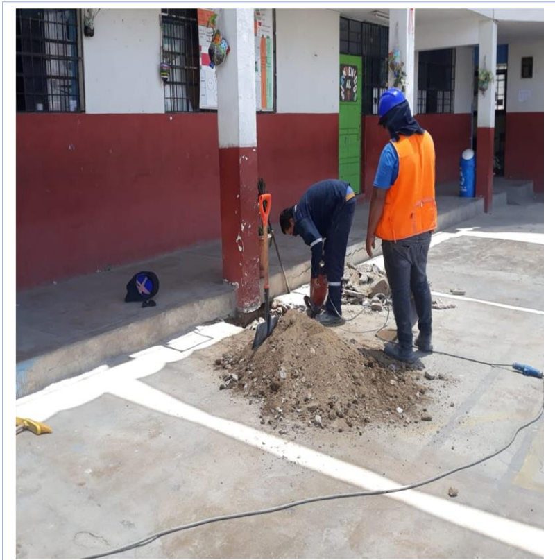
CALICATA -Excavación de calicata para el ensayo mecánica de suelos.
