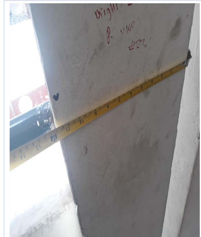
Auscultación del peralte de las columnas
