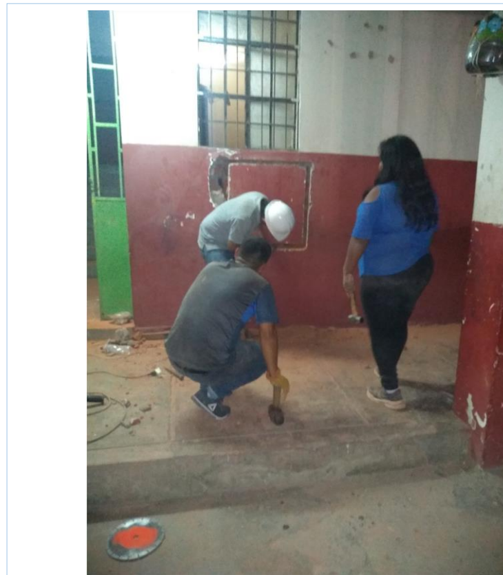
Extracción de murete de pabellón "A" de la IE 20825 – Túpac Amaru II
