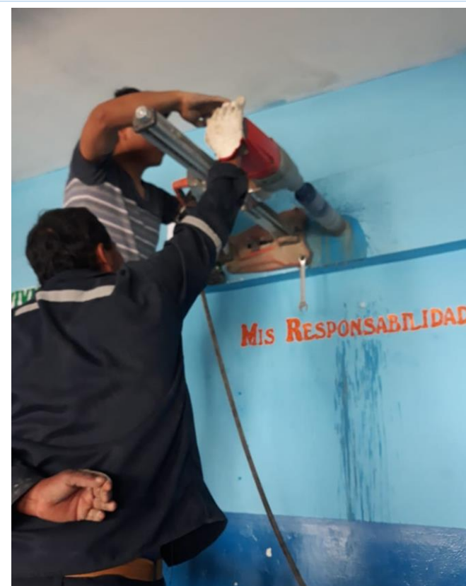
PD – 3 Viga Pabellón B
