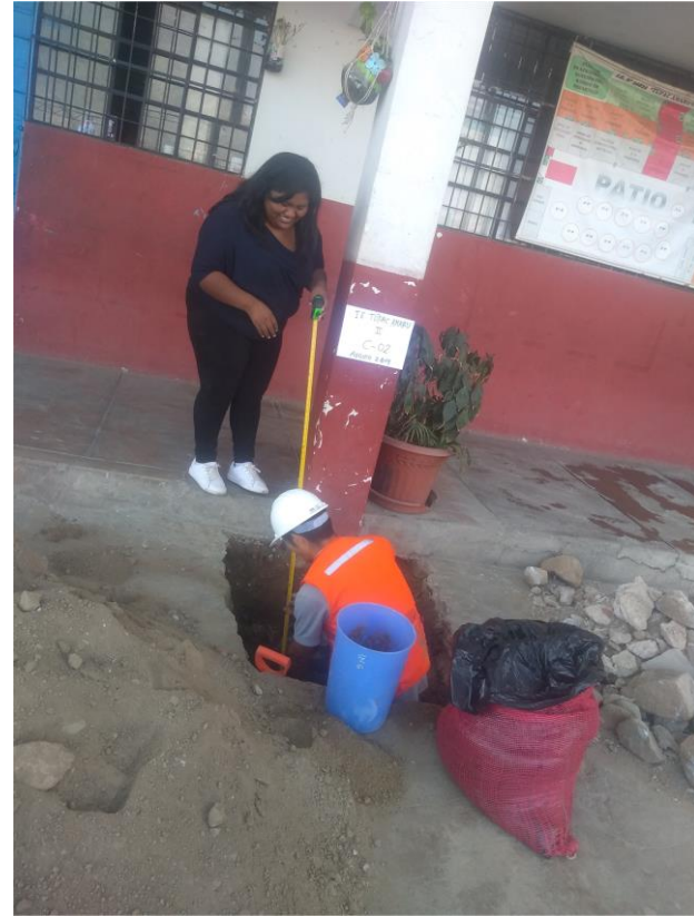
Profundidad de calicata
