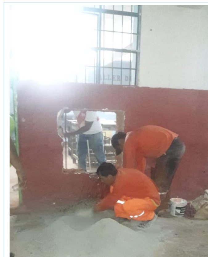
Extracción de murete de pabellón "B" de la IE 20825 – Túnez, Arroyo II
