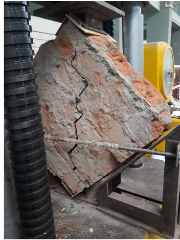
Murete B: Falla por corte diagonal
