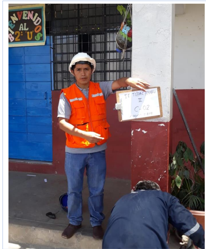
CALICATA -Profundidad de Excavación de calicata.
