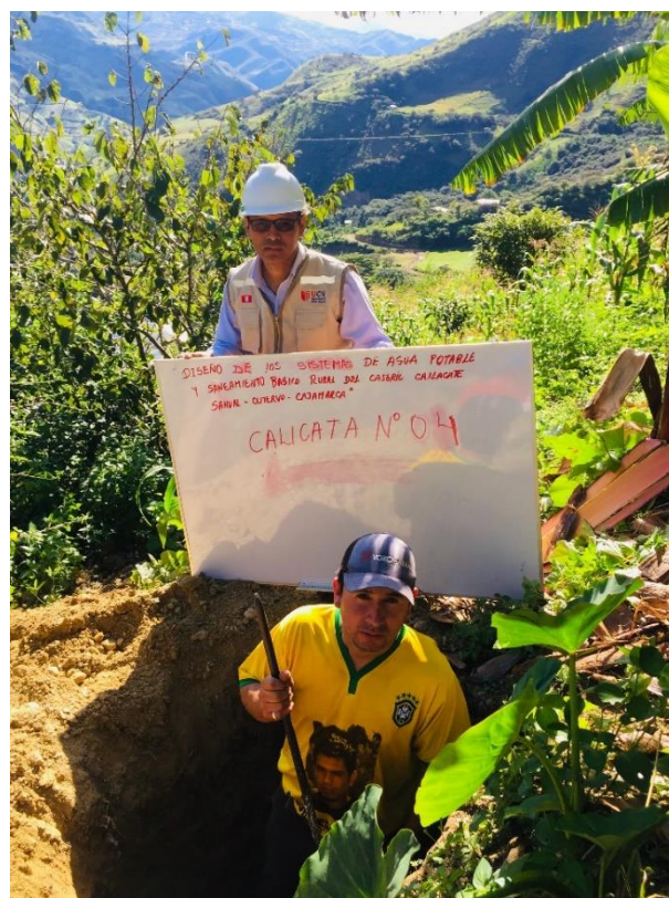
Foto 04: Toma de muestra Calicata N° 04
