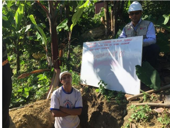
Foto 01: Toma de muestra Calicata N° 01
