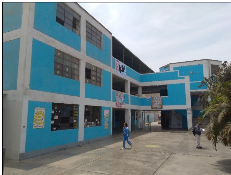
Figura. 10 Edificación de un colegio con el sistema a porticado.
