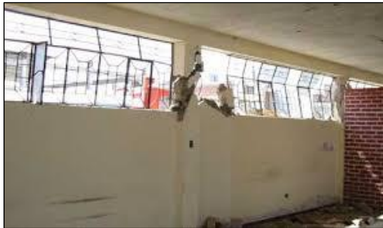
Figura. 6 Efecto de una columna corta
