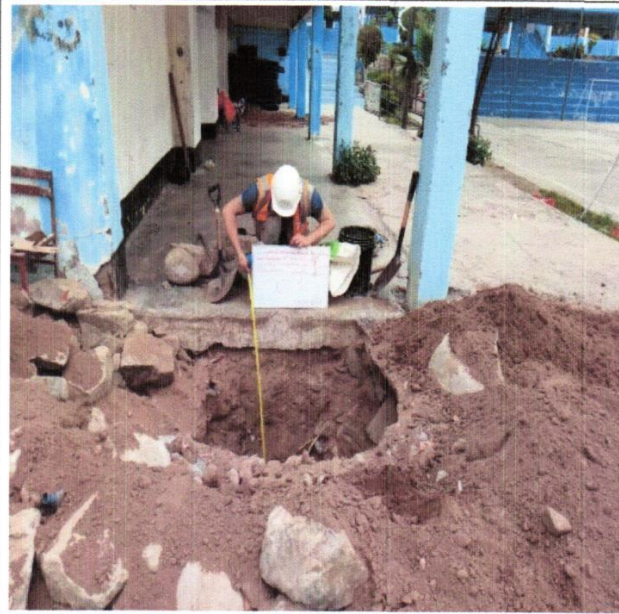
VISTA PANORÁMICA DE LA CALICATA C-1 DEL PROYECTO: "EVALUACION DE LA VULNERABILIDAD SISMICA DEL PABELLON "B" DE LA INSTITUCION EDUCATIVA FELIPE SANTIAGO ESTENOS, PARA SU REFORZAMIENTO ESTRUCTURAL, CHACLACAYO, LIMA 2019", UBICADO EN LA INSTITUCION EDUCATIVA FELIPE SANTIAGO ESTENOS, DISTRITO DE CHACLACAYO - LIMA
