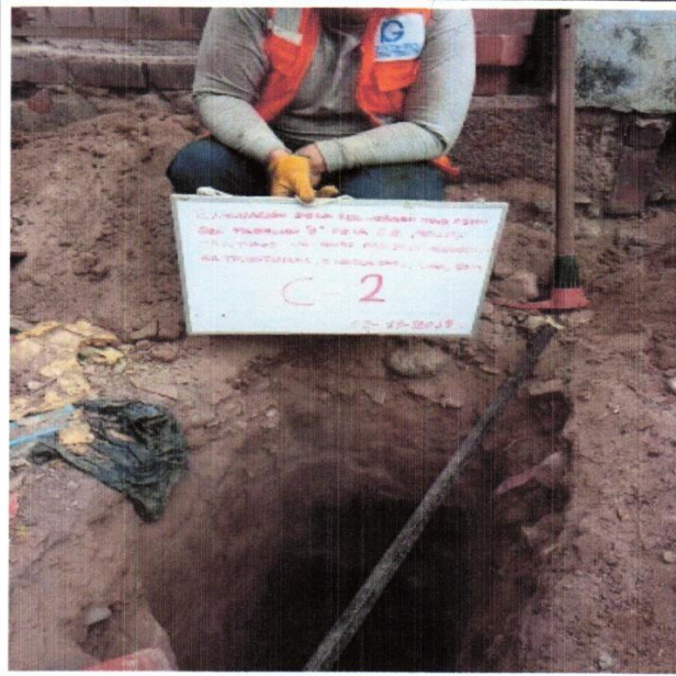
VISTA PANORÁMICA DE LA CALICATA C-2 DEL PROYECTO: "EVALUACION DE LA VULNERABILIDAD SISMICA DEL PABELLON "B" DE LA INSTITUCION EDUCATIVA FELIPE SANTIAGO ESTENOS, PARA SU REFORZAMIENTO ESTRUCTURAL, CHACLACAYO, LIMA 2019", UBICADO EN LA INSTITUCION EDUCATIVA FELIPE SANTIAGO ESTENOS, DISTRITO DE CHACLACAYO - LIMA
