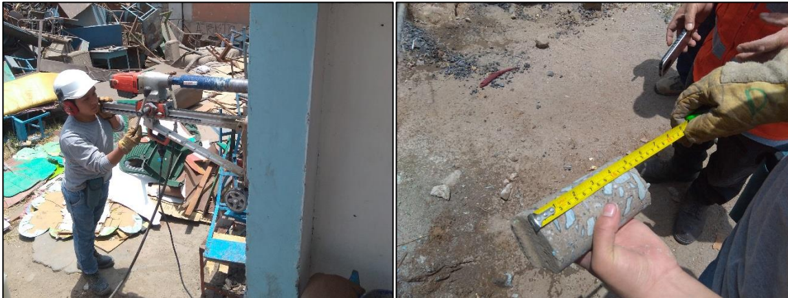
Figura. 31 Extracción de núcleos perforados de vigas, columnas y zapata.
